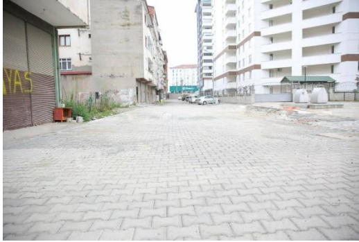
Kaşüstü mah. Bekirbaşıoğlu Sokakta alt ve üst yapı çalışmalarımızı tamamladık
