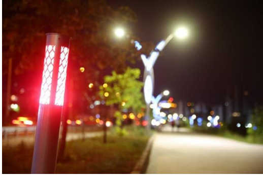
Yürüyüş ve Bisiklet Yolu ile Hürriyet yapımı tamamlanan yer aydınlatma çalışmaları.
