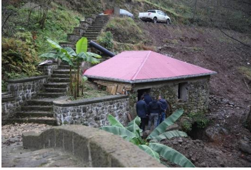
İkisu Mahallemizde aslına uygun olarak yenileme çalışması gerçekleştiriliyor
