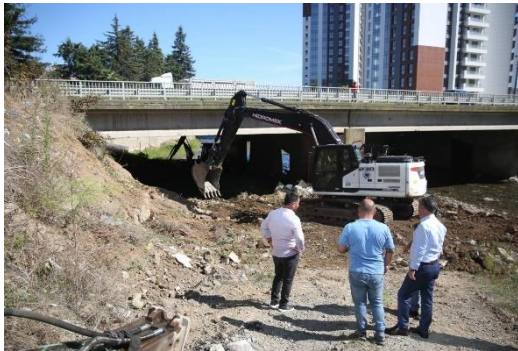
Aksa Doğalgaz çalışmalarına ekipman desteği sağlıyoruz
