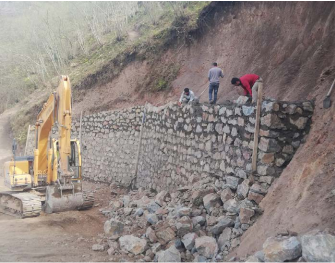
Kayabaşı Mahallesi Soğuksu ve Kirazlık mevkilerinde 4 ayrı istinat duvarı inşa edildi.
