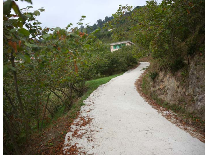
Yenice Mahallesi Yeşilyurt Mevkii'nde iki ayrı noktada yol betonlaması gerçekleştirildi.
