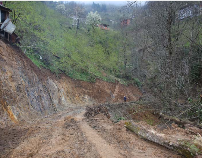
Tepeköy Mahallesi Karahasanlı-Kıran mevkileri arasında yeni yol açıldı.
