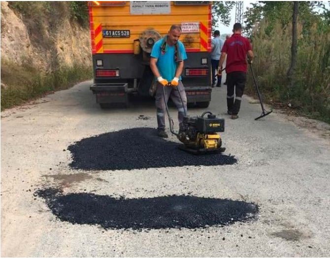
Yokuşlu Mahallesi yollarında asfalt yama çalışmaları gerçekleştirildi.
