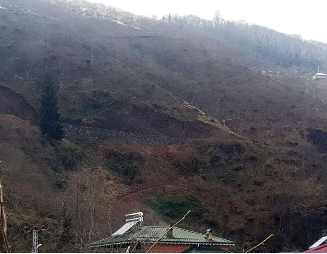
Pınarlı Mahallesi Merkez Mevkii ile Boğazbina Mevkii'ni birbirine bağlayan yolda istinat duvarı yapıldı.
