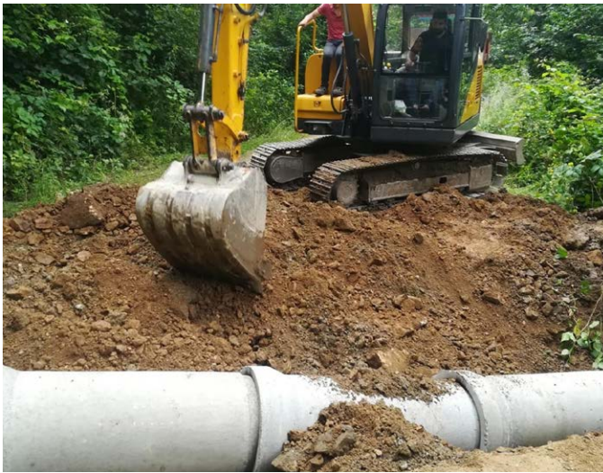
Tandırılı Mahallesi'nde 10 farklı noktada yollardaki dere geçişlerine büz ve boru konularak altyapı çalışması yapıldı. Tandırılı Mahallesi'nde çöp konteynırları yenilendi.
