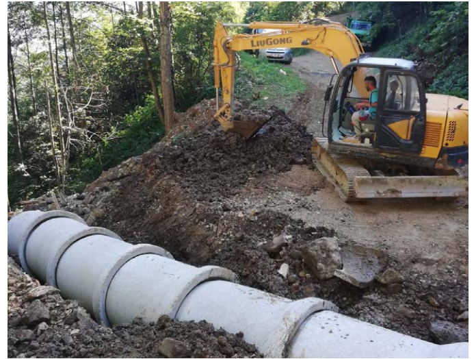
Özdil Mahallesi'nde 30 farklı noktada yollardaki dere geçişlerine büz ve boru konularak altyapı çalışması yapıldı. Özdil Mahallesi'nde çöp konteynırları yenilendi.
