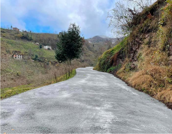
İkisu Mahallesi Afiyans Mevkii - Fulana Mevkii bağlantı yolunda yol genişlemesi yapıldı. Bu yol Trabzon Valiliği tarafından betonlandı.
