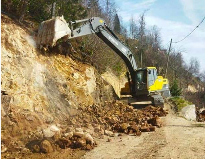
Tandırılı Mahallesi'nde yeni yol yapıldı.
