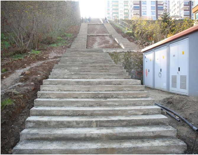
Sancak Mahallesi 1609 Nolu Sokağı Adnan Kahveci Caddesi'ne bağlamak için merdiven yol yapıldı.
