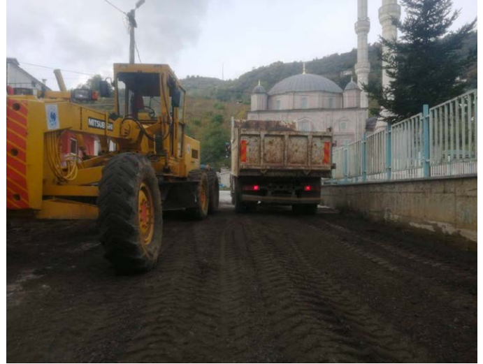
Gürsel Mahallesi'nde 20 farklı noktada yollardaki dere geçişlerine büz ve boru konularak altyapı çalışması yapıldı. Gürsel Mahallesi'nde çöp konteynırları yenilendi.
