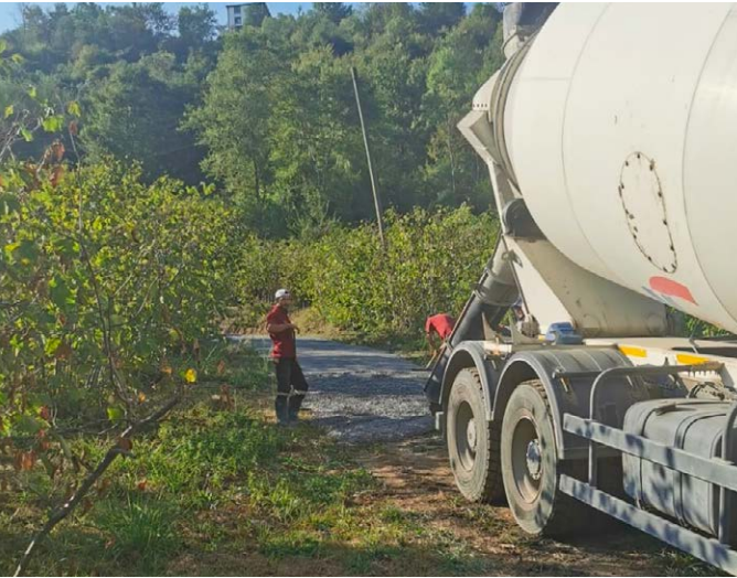
Yokuşu Mahallesi yol betonlaması yapıldı.
