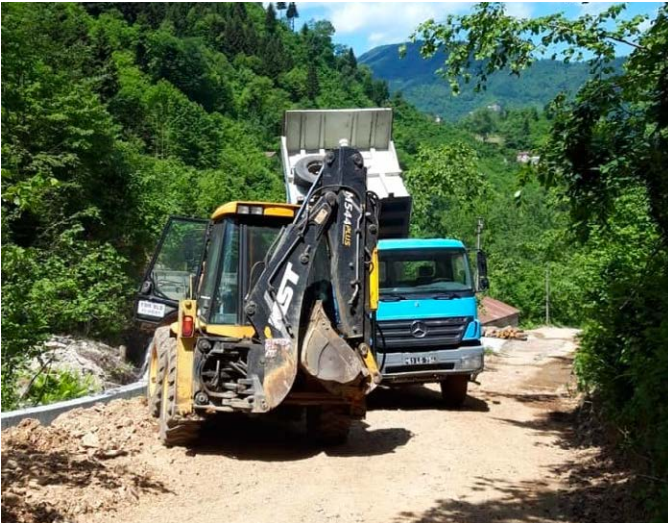
Ocak Mahallesi'nde 10 farklı noktada yollardaki dere geçişlerine büz ve boru konularak altyapı çalışması yapıldı. Ocak Mahallesi'nde çöp konteynırları yenilendi.
