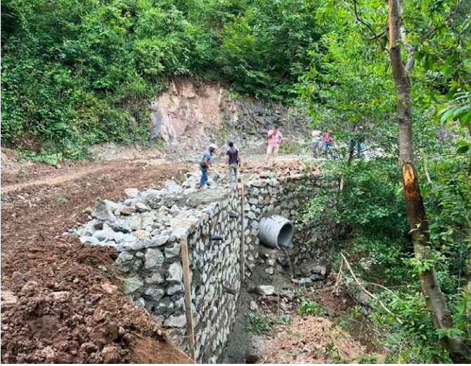
Gülyurdu Mahallesi Ekşili ve Muguzi Mevkii'nde istinat duvarları inşa edildi.
