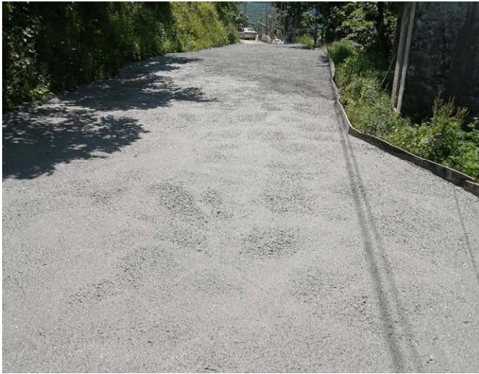
Taşdelen Mahallesi Örgülü Mevkii Camii çevresinde yol betonlaması yapıldı.
