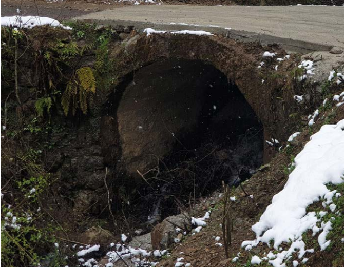
Gülyurdu Mahallesi - Kıratlı Mahallesi bağlantı yolunda bulunan tarihi köprü onarıldı.
