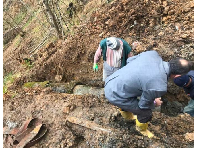
Yenice Mahallesi'nde 15 farklı noktada yollardaki dere geçişlerine büz ve boru konularak altyapı çalışması yapıldı. Yenice Mahallesi'nde çöp konteynırları yenilendi.
