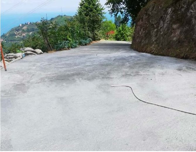
Sancak Mahallesi'nde (ilçe merkezi ve kırsalı) muhtelif alanlarda yol betonlamaları yapıldı.
