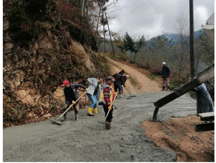
Demirciler Mahallesi Pazarcık Mevkii'nde yol betonlaması yapıldı.
