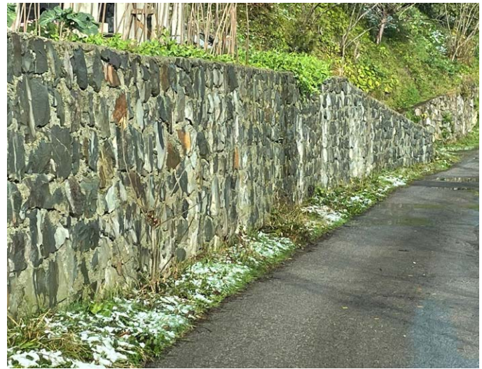
Gürsel Mahallesi Yavuzlar Mevkii'nde menfez ve istinat duvarı imalatları yapıldı.
