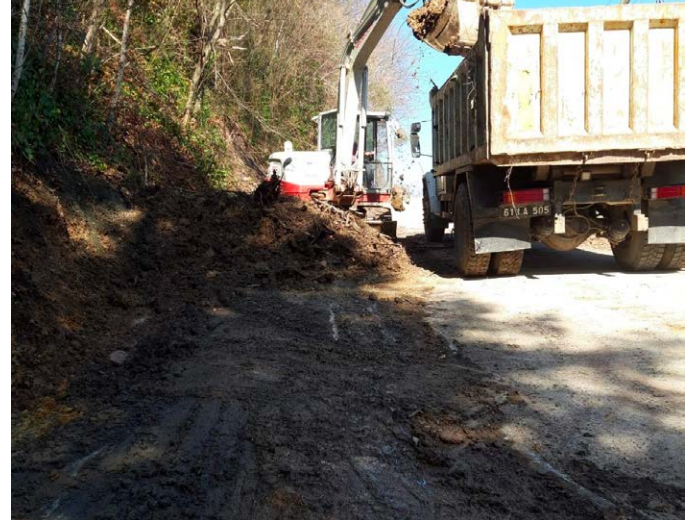
Şanlı Mahallesi'nde menfezlerde temizlik çalışması yapıldı.
