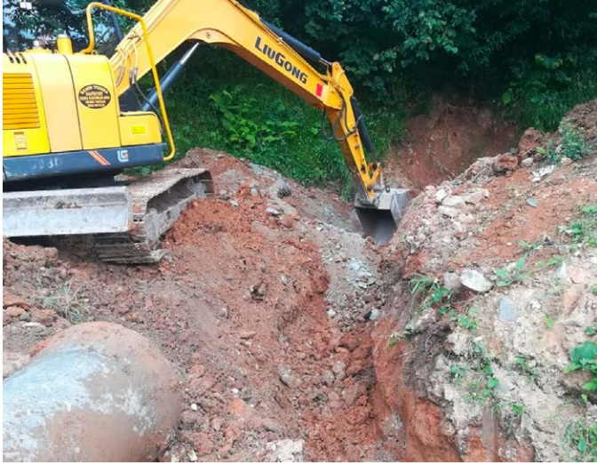
Sancak Mahallesi kırsalında 20 farklı noktada yollardaki dere geçişlerine büz ve boru konularak altyapı çalışması yapıldı.
