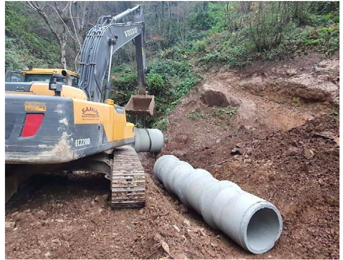
Kayabaşı Mahallesi'nde 40 farklı noktada yollardaki dere geçişlerine büz ve boru konularak altyapı çalışması yapıldı. Kayabaşı Mahallesi'nde çöp konteynırları yenilendi.
