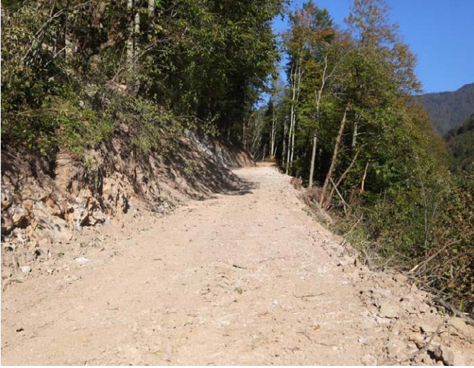
Demirciler Mahallesi Deremahalle Mevkii'nde yeni yol açıldı.
