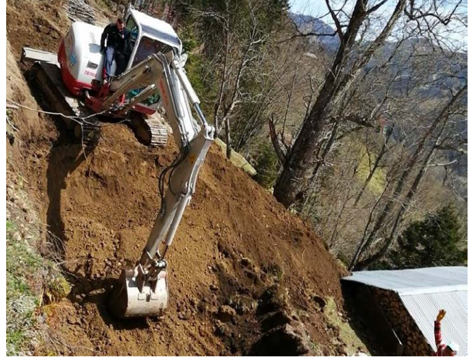
Demirciler Mahallesi Yukarımahalle Mevkii'nde belediye-vatandaş işbirliği ile 2 ayrı yeni yol açıldı.
