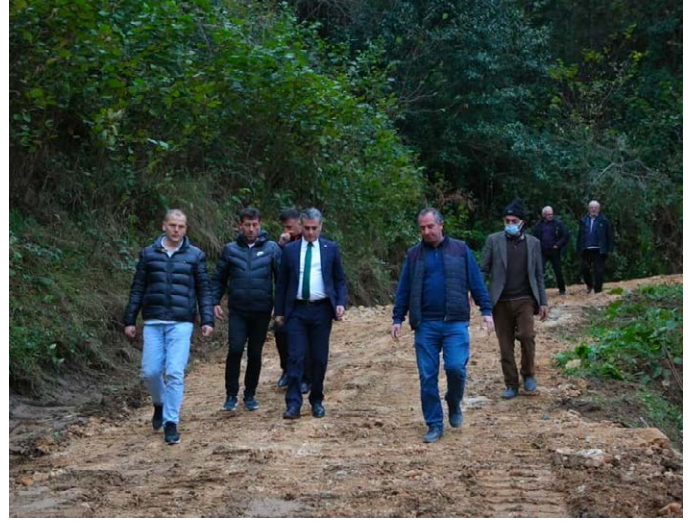
Taşdelen Mahallesi Seydioğlu Mevkii'nde yol genişleme çalışması gerçekleştirildi.
