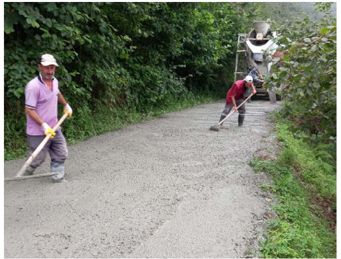
Kıratlı Mahallesi Fırıcık Mevkii'nde yol betonlaması gerçekleştirildi.
