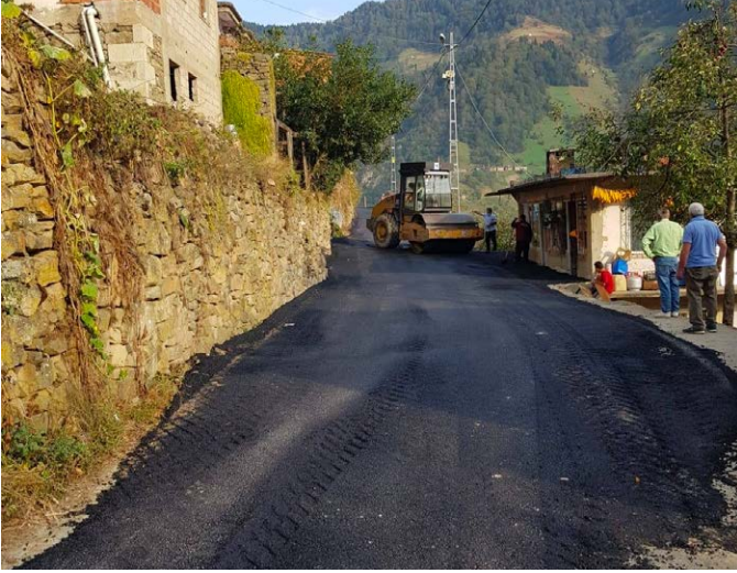
Çamlıyurt Mahallesi'nde asfaltma yapıldı.
