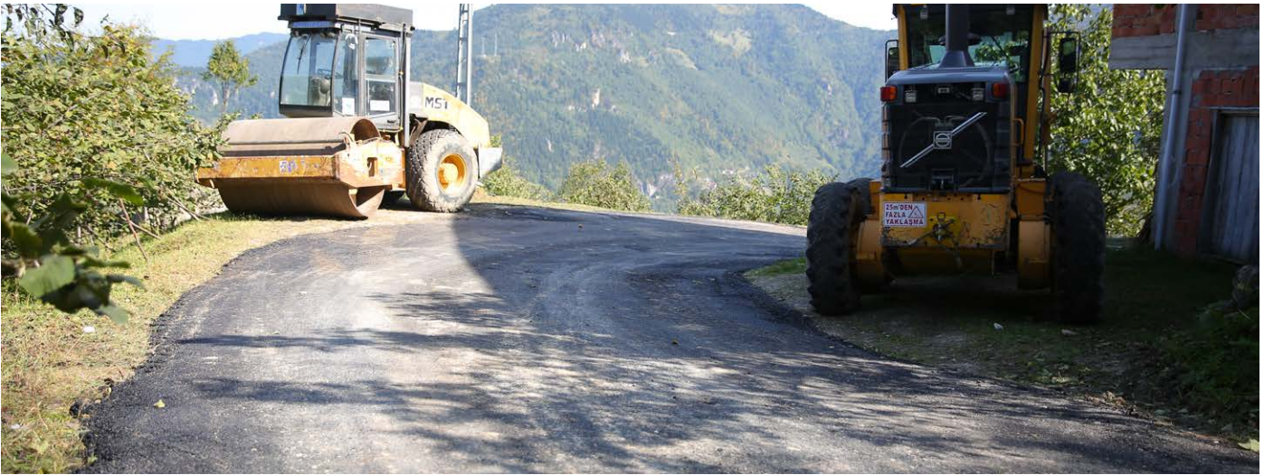
Maden Mahallesi Sırtlı Mevkii'nde asfaltlama yapıldı.
