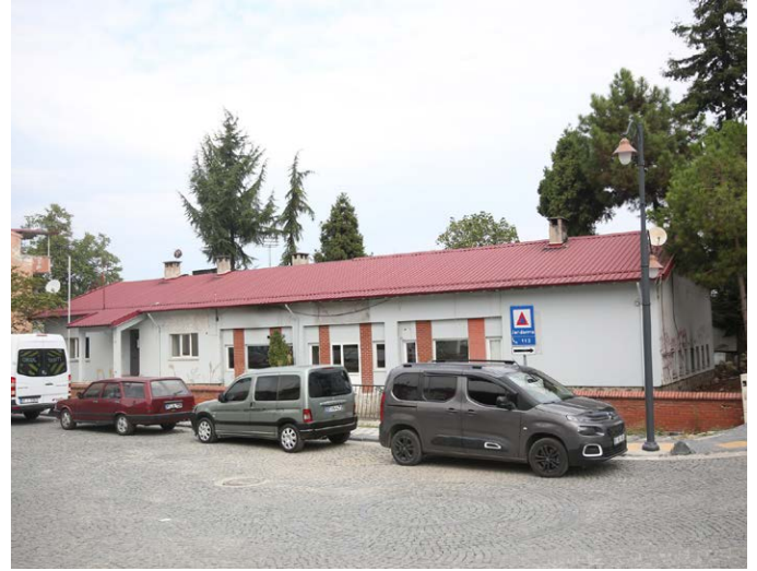
Sancak Mahallesi'nde bulunan eski ilçe emniyet müdürlüğü'nün olduğu arazi devralındı. Eski bina yıkıldı. Yeni dönemde bu alan soysal alan olarak düzenlenecektir.
