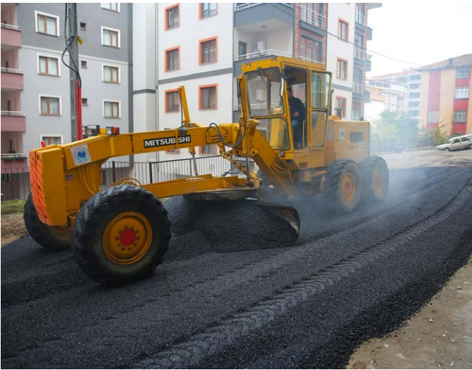
Gürsel Mahallesi Okul Küme Evleri Mevkii'nde asfaltlama çalışması gerçekleştirildi.
