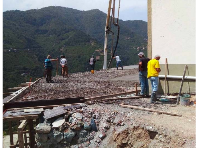
Ocak Mahallesi Camii'nin tekrar faaliyete geçebilmesi için çevre duvarı yapıldı.
