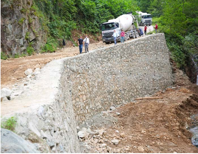
Taşdelen Mahallesi Avcıoğlu Mevkii'nde istinat duvarı ve açık kanal imalatı yapıldı.
