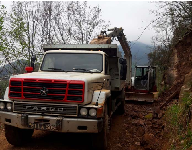
Şanlı Mahallesi'nde 10 farklı noktada yollardaki dere geçişlerine büz ve boru konularak altyapı çalışması yapıldı. Şanlı Mahallesi'nde çöp konteynırları yenilendi.
