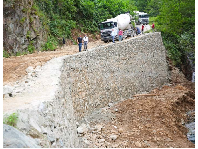
Taşdelen Mahallesi Hamo, Örgülü, Mollaömerler, Kuruırmak mevkileri bağlantı yolunda sel ve heyelan nedeniyle istinat duvarları inşa edildi.
