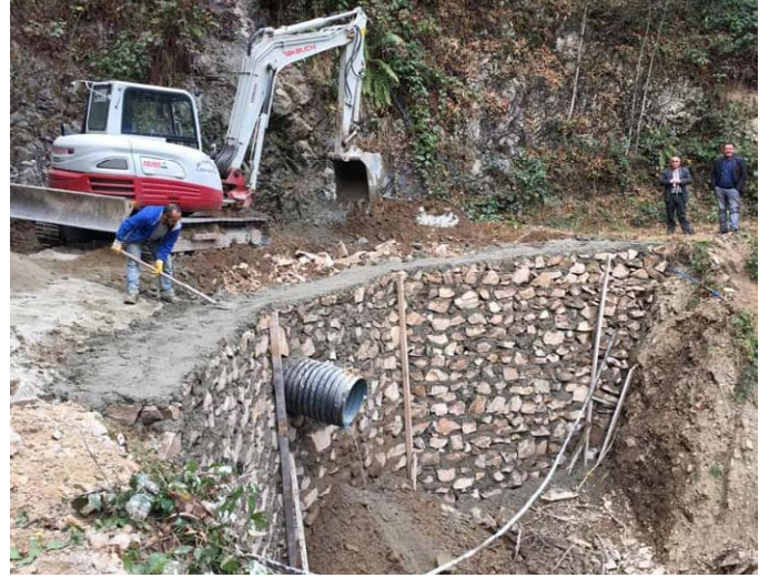
Tepeköy Mahallesi Demircioğulları, Karahasanlı, Kıran ve Okul mevkilerinde istinat duvarları inşa edildi.
