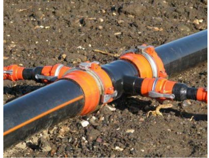
Tandırılı Mahallesi'ne vatandaşların yaşadığı su sorununun çözümü için 3 bin metre su borusu temin edildi. Ayrıca sahadaki su şebekesi yapım çalışmalarına katkı verildi.
