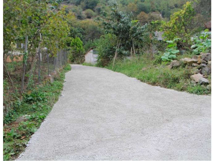
İkisu Mahallesi Aşğı Camii Mevkii'nde yol betonlaması yapıldı.
