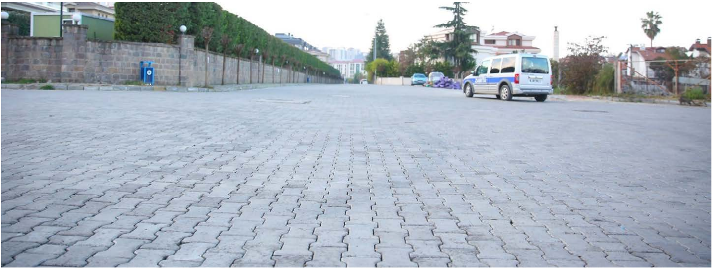
Kaşüstü Mahallesi'nin Devlet karayolu Caddesi kuzeyinde bulunan (Villalar bölgesinde) detaylı altyapı çalışmalarının ardından gerekli üstyapı çalışmaları ivedilikle gerçekleştirildi. Böylece yaşam alanı kötü görüntüden kurtarılarak modern görüntüye kavuşturuldu.
