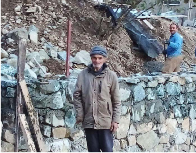
Ocak Mahallesi Değirmen Mevkii'nde mahalle sakinleri tarafından yapılan istinat duvarına destek verildi.
