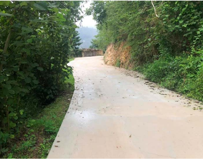
Kayabaşı Mahallesi'nde Trabzon Valiliği ile birlikte yol betonlaması yapıldı.
