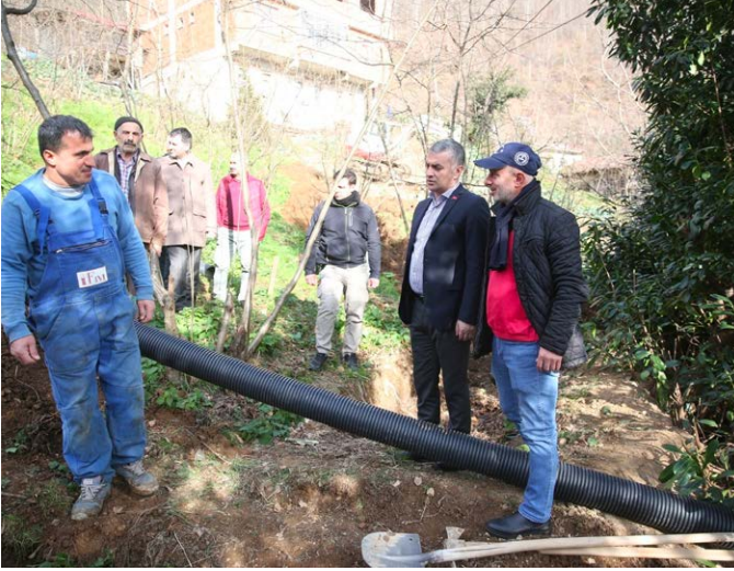
Özdil Mahallesi Yenimahalle Mevkii'nde yapılan kanalizasyon çalışmasına destek olundu.
