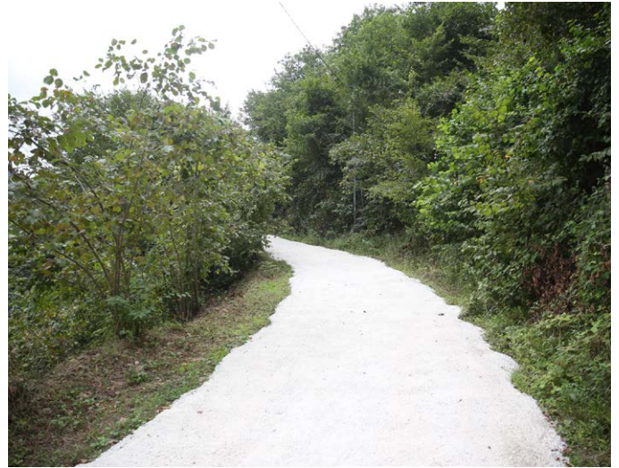
Taşdelen Mahallesi Hamo Camii çevresinde betonlama gerçekleştirildi.
