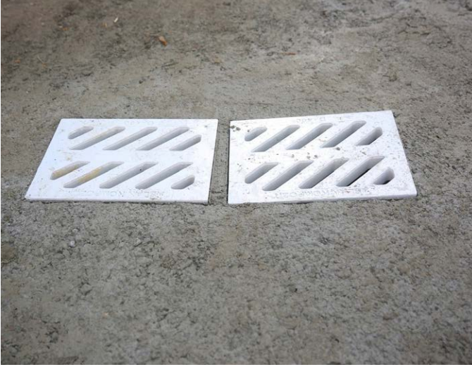
Sancak Mahallesi Dursun Şahin Caddesi'nde altyapı çalışmalarının ardından kaldırım imalatları gerçekleştirildi.
