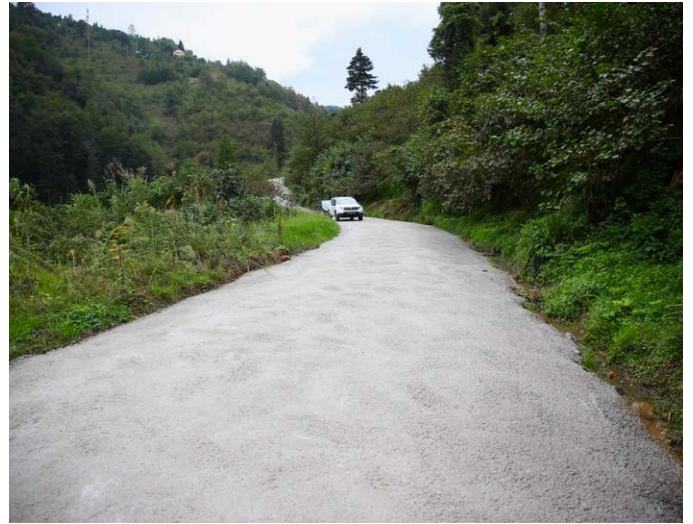
Kömürcü Mahallesi Alaşlı Mevkii'nde yol betonlaması gerçekleştirildi.
