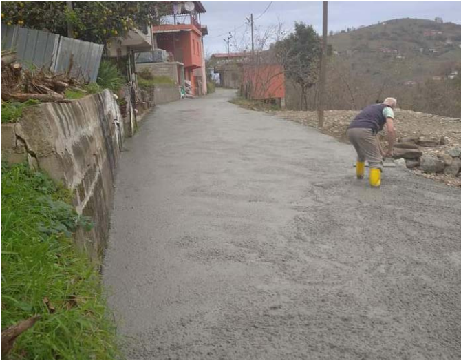
Yokuşlu Mahallesi Özcanlar Mevkii'nde yol betonlaması yapıldı.
