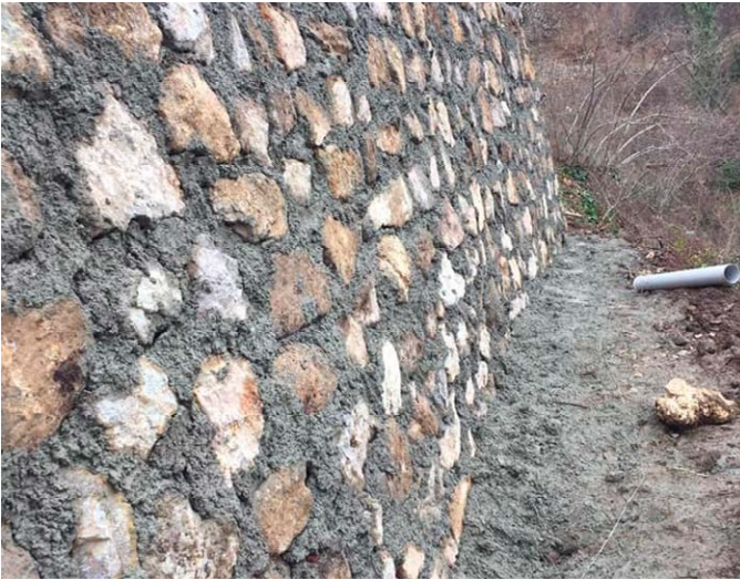
Kayabaşı Mahallesi Kirazlık Mevkii'nde istinat duvarı yapıldı.
