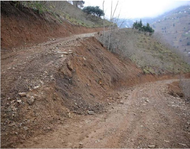
Ocak-Kıratlı-Taşdelen mahalleleri bağlantısı için yeni yol açıldı.
