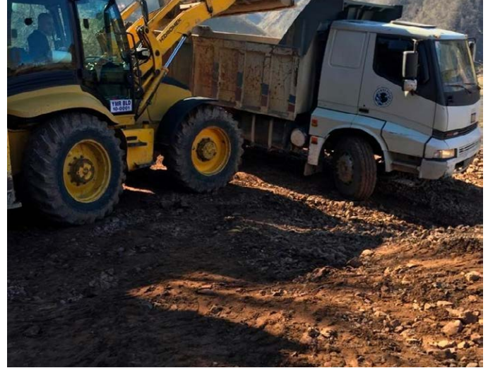
Kayabaşı Mahallesi'nde viraj genişlemesi yapıldı.
