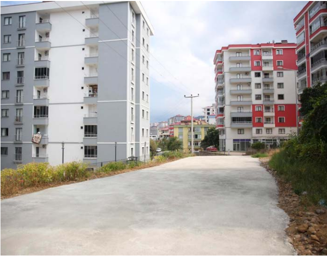
Kaşüstü Mahallesi merkezi ve kırsalında muhtelif alanlarda çok sayıda yeni imar yolu açıldı. Mahalle merkezinde açılan imar yollarının tümü betonlandı.
