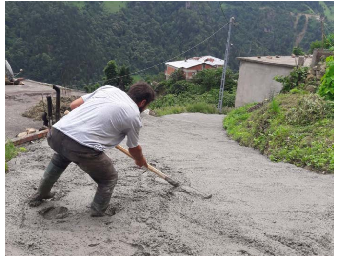
Çamlıyurt Mahallesi Musalar Mevkii'nde yol betonlaması yapıldı.
