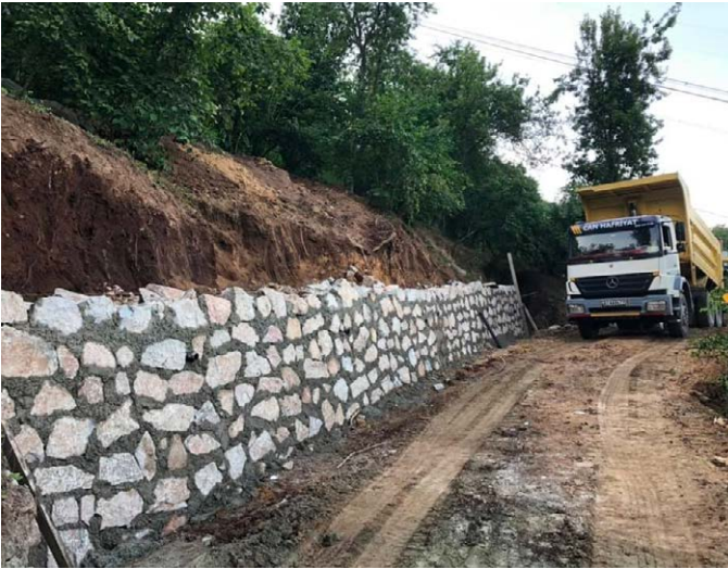
Yenice Mahallesi'nde istinat duvarı yapıldı.
