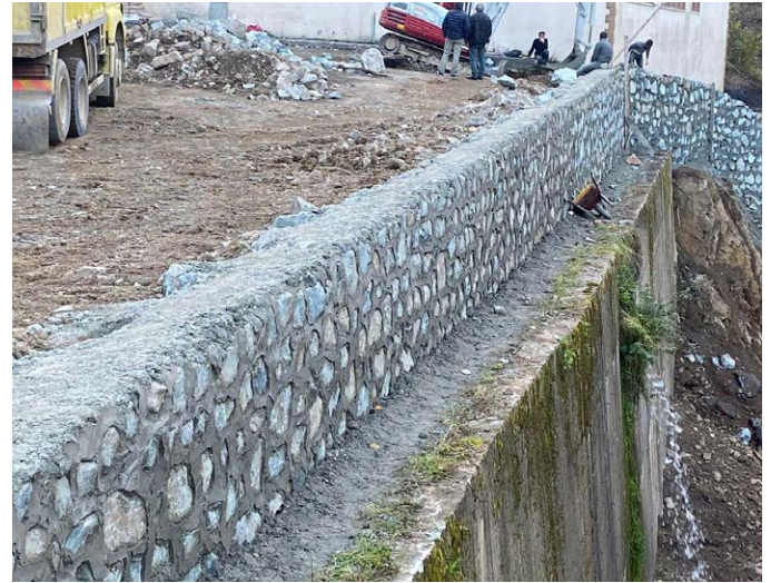
Oymalı Mahallesi Sedat Kaplan Ortaokulu çevresinde istinat duvarı yapıldı. Ayrıca çevre düzenlemesi gerçekleştirildi.
