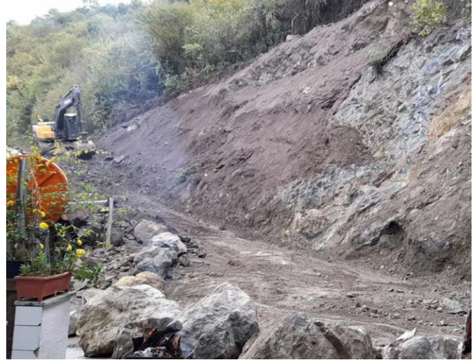
Çınarlı Mahallesi Kılıçtepe Mevkii 112 istasyonu üst bölgesinde viraj genişlemesi yapıldı.
