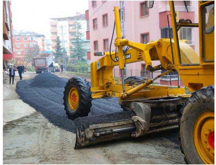
Sancak Mahallesi'nde (ilçe merkezi ve kırsalı) muhtelif alanlarda asfaltlama çalışmaları yapıldı.
