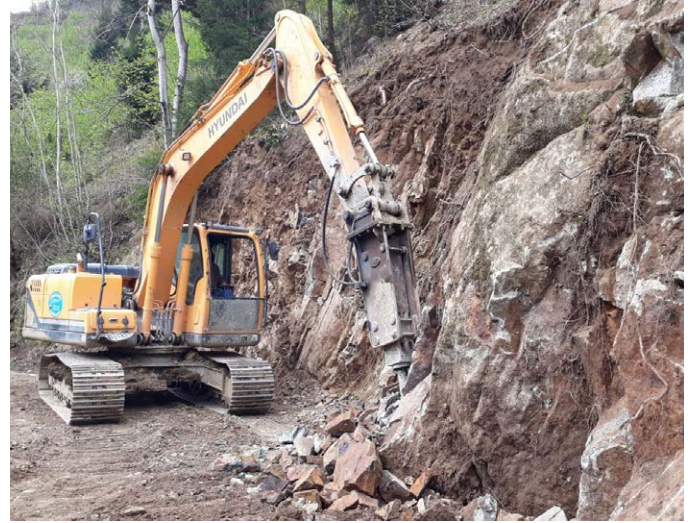
Kıratlı Mahallesi'ne ulaşımı sağlayan ana yolda 8 km yol genişlemesi yapıldı.
