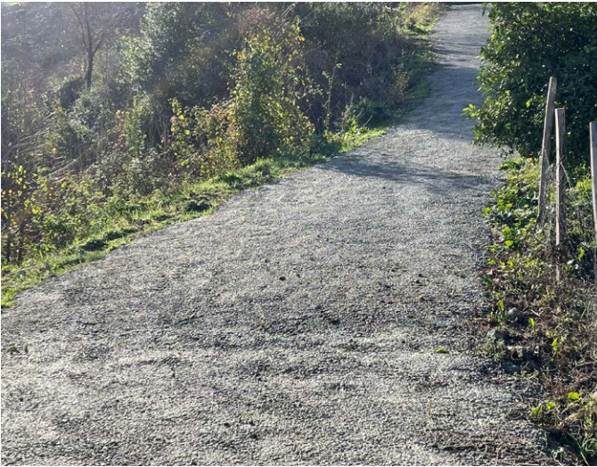
Namikkemal Mahallesi Yenimahalle Mevkii'nde yeni yol açıldı ve yol betonlaması yapıldı.
