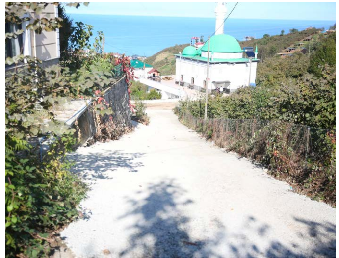
Çınarlı Mahallesi Konak Camii yanında yol betonlaması yapıldı.
