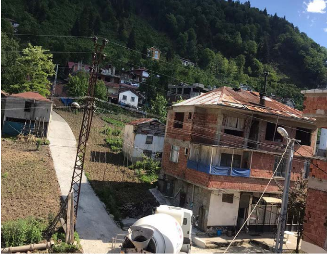
Oymalı Mahallesi Düzmahalle Mevkii'nde yol betonlaması yapıldı.
