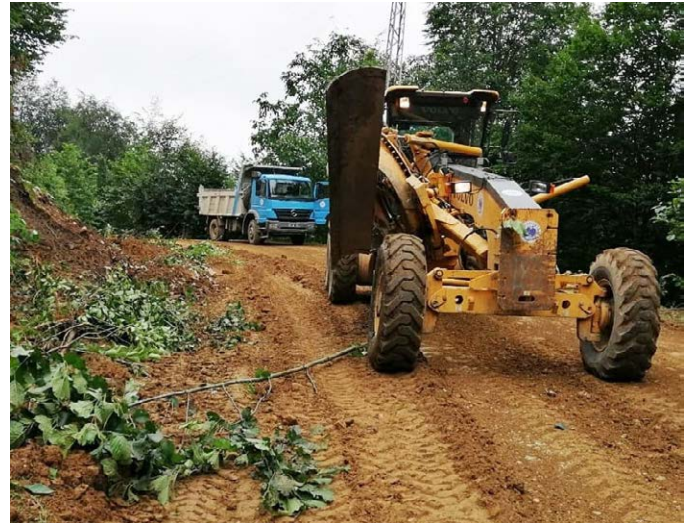
Demirciler Mahallesi Ayor Deresi Mevkii'nde 1,5 km, Ağıllı Mevkii'nde 2 km, Gedik Mevkii'nde 1 km, Cami Sokak'ta 300 metre yol genişlemesi yapıldı.
