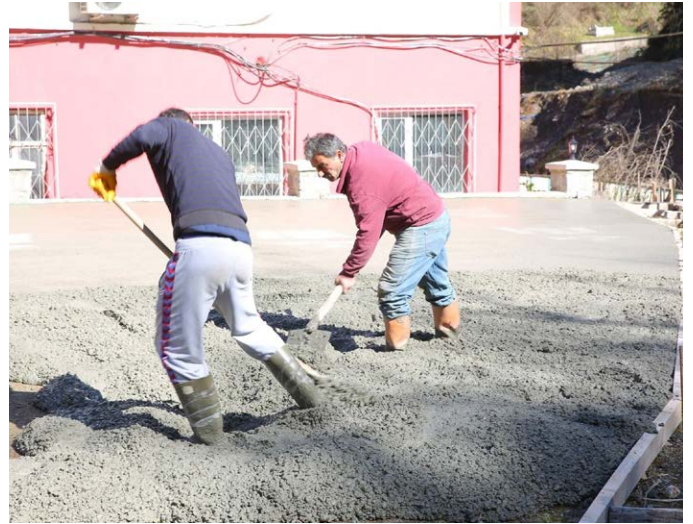
Kömürcü Mahallesi Kozdeğirmen Camii avlusu betonlandı.
