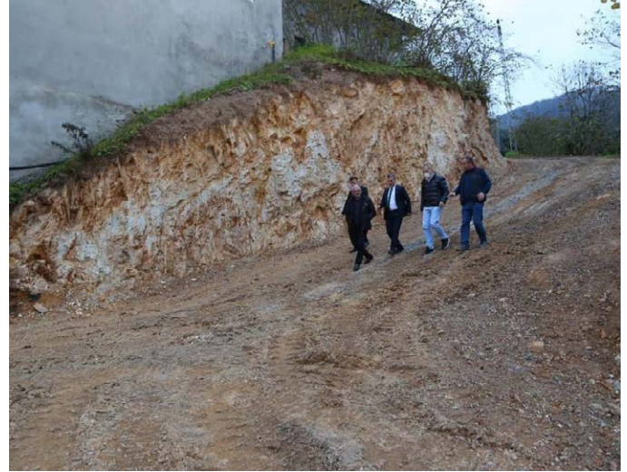
Taşdelen Mahallesi Şahinler Mevkii'nde viraj genişlemesi ve yol betonlaması yapıldı.
