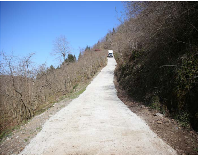
Çınarlı Mahallesi Konak Mevkii'nde yol betonlaması yapıldı.
