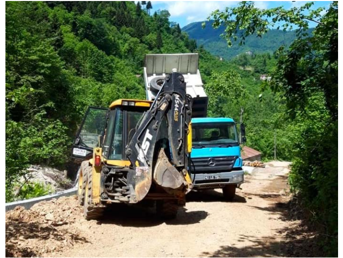
Oymalı Mahallesi'nde 20 farklı noktada yollardaki dere geçişlerine büz ve boru konularak altyapı çalışması yapıldı. Oymalı Mahallesi'nde çöp konteynırları yenilendi.
