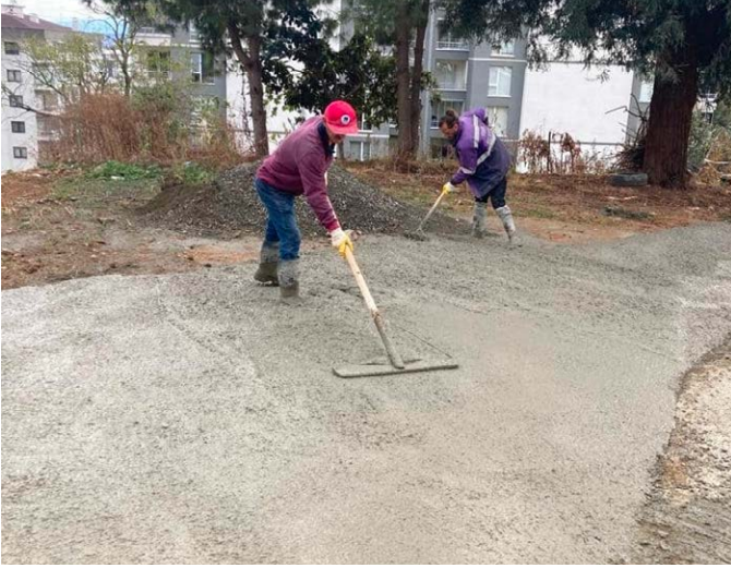
Kaşüstü Mahallesi'nde yapılan doğalgaz ve diğer altyapı çalışmalarının ardından yol onarım çalışmaları ivedilikle gerçekleştirildi.
