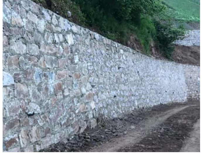
Çamlıyurt Mahallesi'nde istinat duvarları yapıldı.
