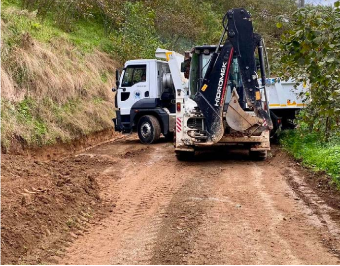
Pınarlı Mahallesi'nde 10 farklı noktada yollardaki dere geçişlerine büz ve boru konularak altyapı çalışması yapıldı. Pınarlı Mahallesi'nde çöp konteynırları yenilendi.
