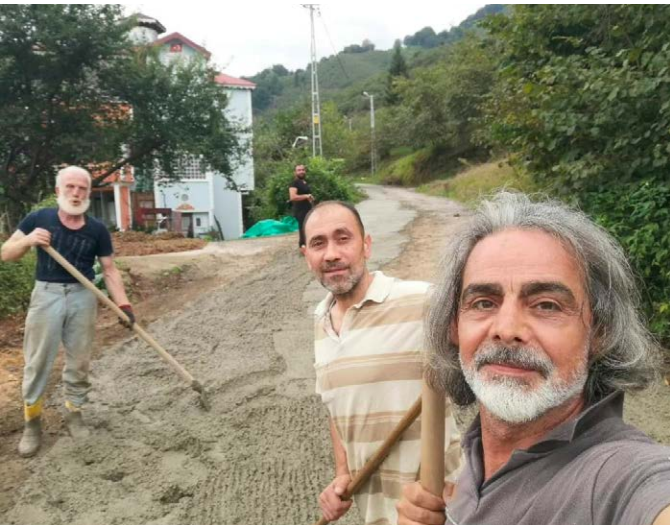
Yenice Mahallesi Camii Mevkii'nde yol betonlaması gerçekleştirildi.
