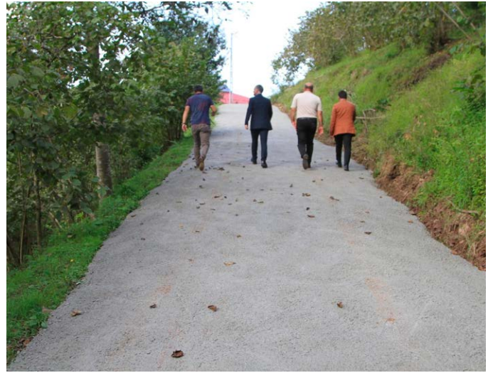
İkisu Mahallesi Afiyans Mevkii'nde yol betonlaması yapıldı.
