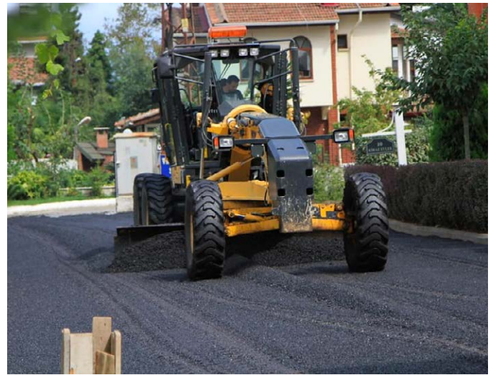
Taşdelen Mahallesi Avcioğlu Mevkii'nde asfaltlama çalışması gerçekleştirildi.
