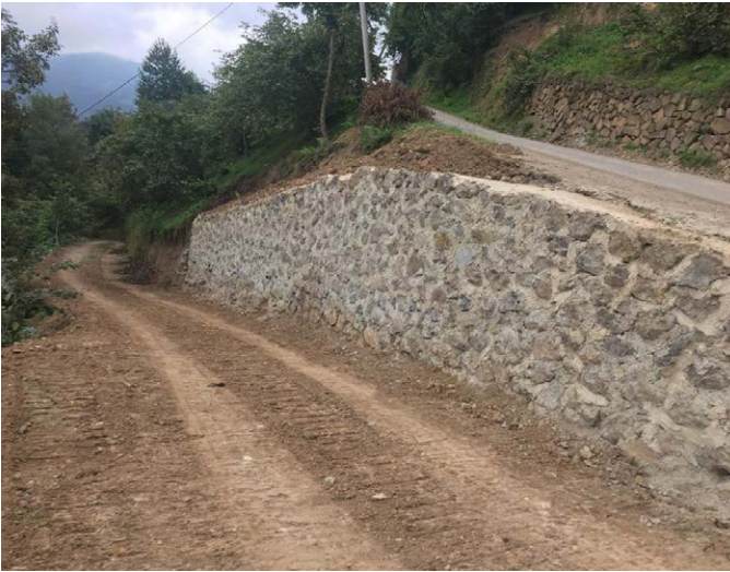
Kayabaşı Mahallesi'ni Kömürcü Mahallesi'ne bağlayan yolun alt ve üst kısımlarında istinat duvarları inşa edilerek heyelan tehlikesi ortadan kaldırıldı.
