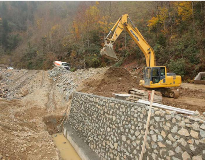
Demirciler Mahallesi Pazarcık ve Yukarımahalle mevkilerinde heyelandan zarar gören muhtelif alanlarda istinat duvarları inşa edildi.
