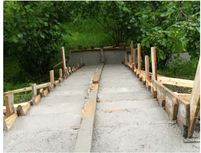
İkisu Mahallesi'nde mübarek şehit kabrine ulaşım için merdivenli yol yapıldı.
