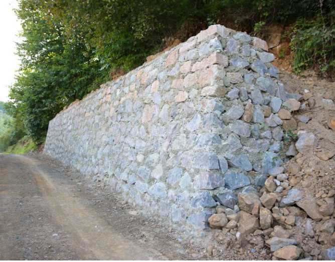
Yenice Mahallesi'nde 8 ayrı istinat duvarı yapıldı.
