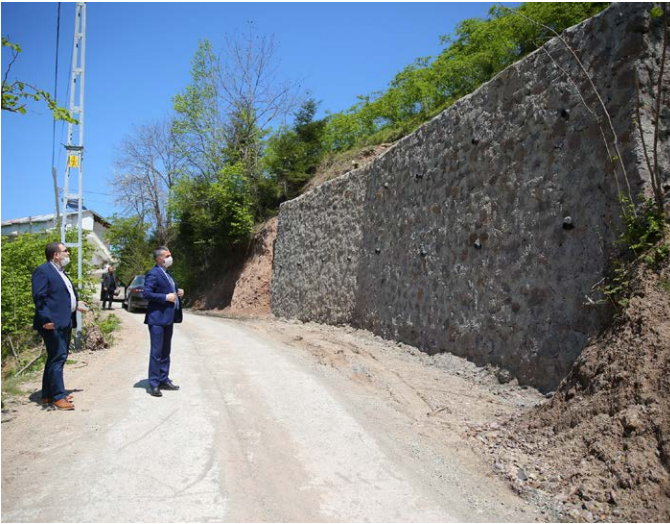
İkisu Mahallesi Fulana Mevkii'nde iki ayrı noktada (cami önü ve şehit yolunda) ve Afiyans Mevkii'nde istinat duvarı yapıldı.
