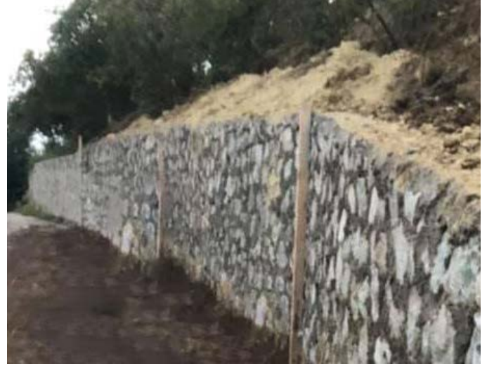
Yokuşlu Mahallesi Hacıoğlu Mevkii'nde belediye-vatandaş işbirliği ile istinat duvarı yapıldı.
