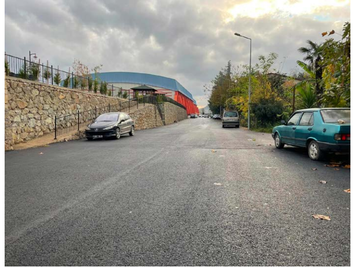
Sancak Mahallesi'nde Jimnastik Salonu ile İlçe Jandarma Komutanlığı arasındaki yolda altyapı ve genişleme çalışmaları yapıldı. Ardından yolun Büyükşehir Belediyesi tarafından asfaltlanması sağlandı.
