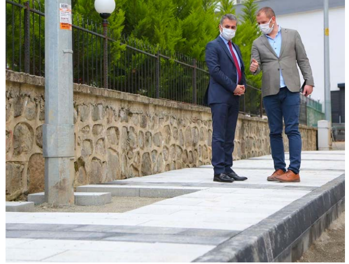
Kaşüstü Mahallesi merkezinde muhtelif alanlarda kaldırım imalatları yapıldı. Böylece yayalar için yol güvenliği sağlandığı gibi mahalle merkezi kaldırımlarına kavuşturulmuş oldu.
