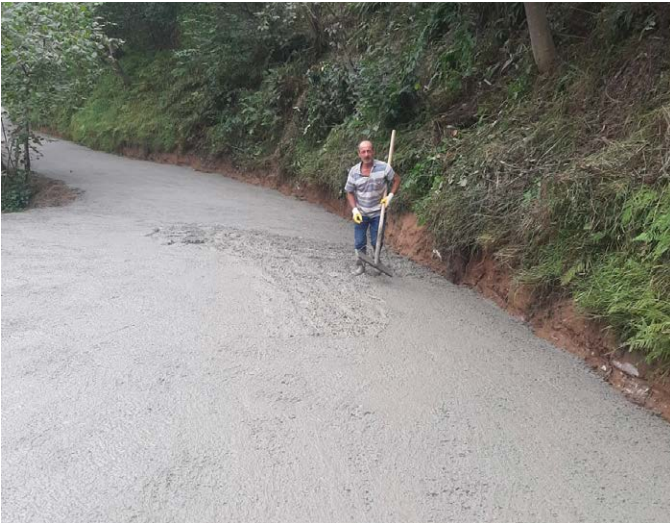
Tepeköy -Demirciler bağlantı yolunda betonlama yapıldı.
