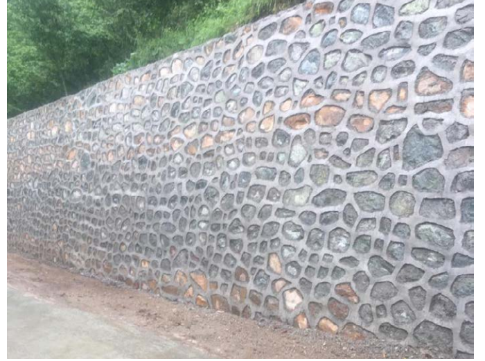
Gülyurdu Mahallesi Kukaslı Mevkii'nde istinat duvarı inşa edildi.
