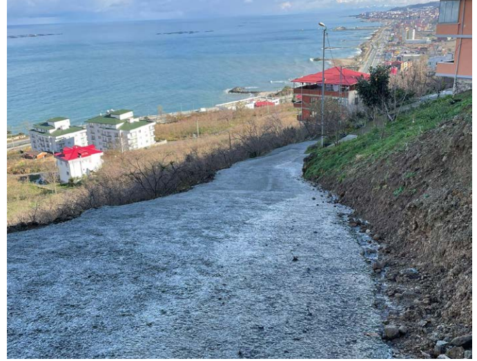
Namikkemal Mahallesi Vanelya Mevkii'nde yol betonlama çalışması gerçekleştirildi.
