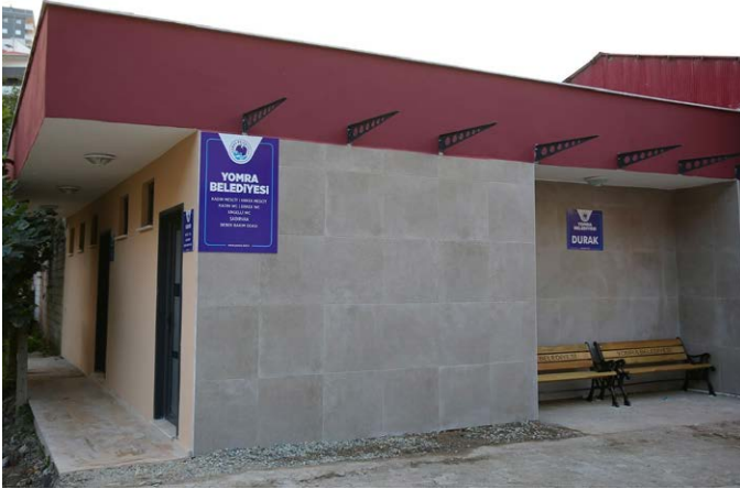
Namikkemal Mahallesi sanayi alanında halkımızın ihtiyaçlarına cevap verebilmek için içerisinde bay-bayan Wc'ler, kapalı otobüs durağı, şadırvan, bay-bayan mescit ve çocuk bakım odası bulunan umumi tuvalet imal edildi.
