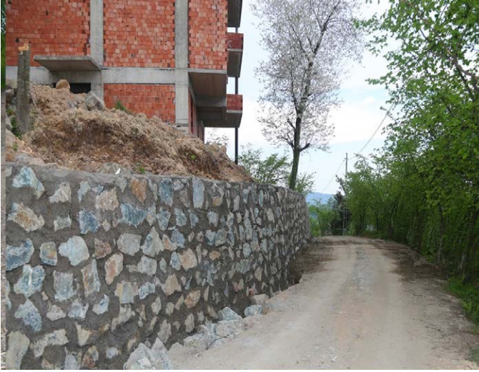
Yokuşlu Mahallesi'nde istinat duvarı inşa edildi.
