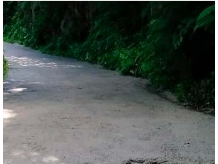
Taşdelen Mahallesi Gogal Mevkii'nde yol betonlaması yapıldı.
