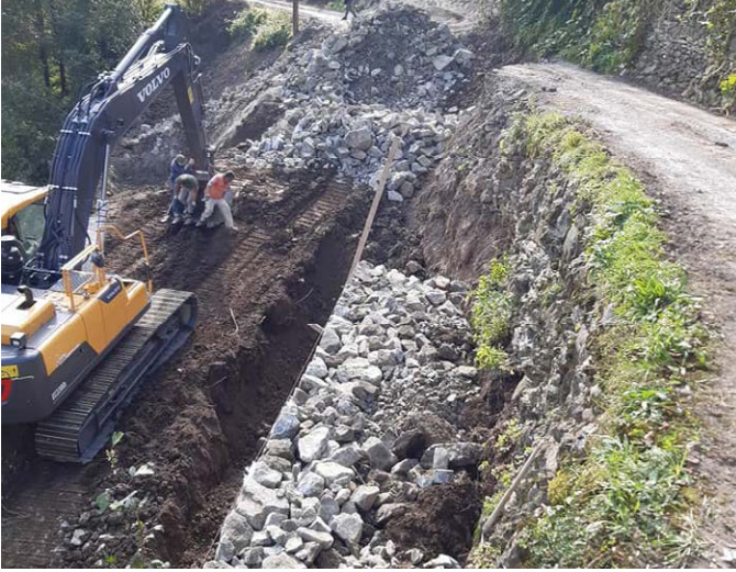
Kılıçlı Mahallesi Düz Mevkii'nde istinat duvarı yapıldı.
