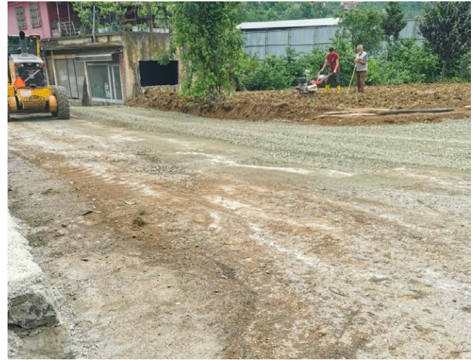
Çamlıca Mahallesi girişi Değirmenönü Mevkii'nde yol genişlemesi ve betonlama çalışması yapıldı.
