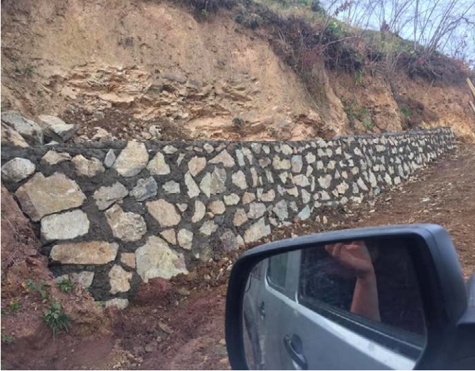
Kayabaşı Mahallesi'nde iki ayrı istinat duvarı daha yapıldı.
