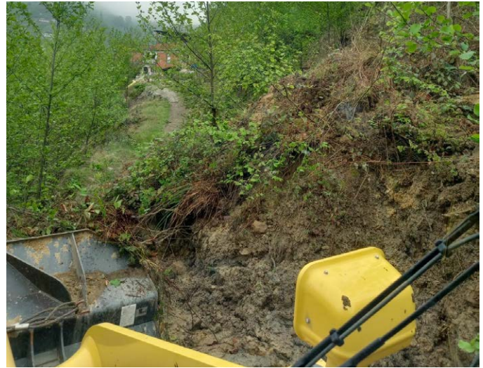
Taşdelen Mahallesi Gogal-Avcıoğulları ve Küçükler mevkilerinde 4 ayrı yeni yol açıldı.
