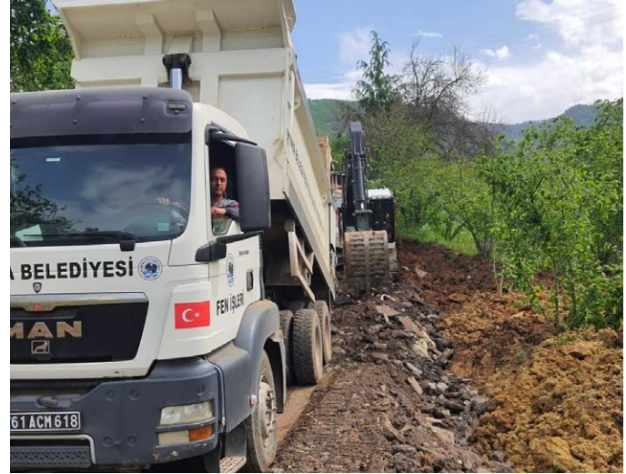
İkisu Mahallesi Sirt Mevkii'nde yol dolgu çalışması yapıldı.
