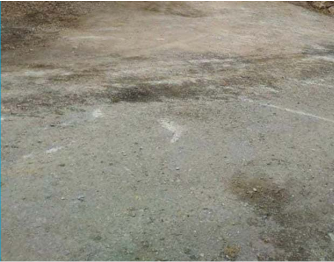
Özdil Mahallesi Durançay Mevkii'nde yol betonlaması yapıldı.
