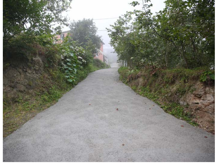
Tepeköy Mahallesi Kale Mevkii'nde yol betonlaması yapıldı.
