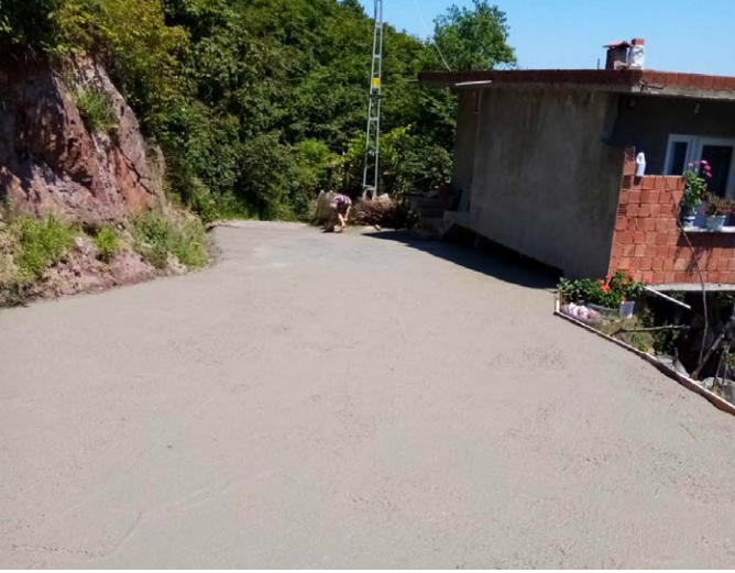
Kayabaşı Mahallesi Hurmalık Mevkii'nde iki ayrı noktada yol betonlaması gerçekleştirildi.
