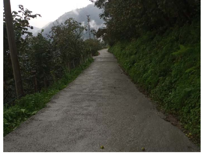
Oymalı Mahallesi Yeşilpınar – Elmalık mevkileri arasında yol betonlaması gerçekleştirildi.
