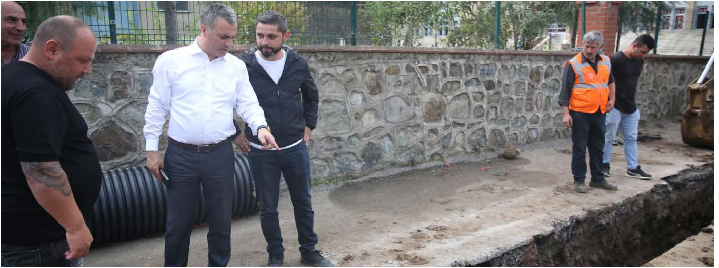
Sancak Mahallesi'nde muhtelif alanlarda (Dursun Şahin Caddesi, Adnan Kahveci Caddesi, Hükümet Caddesi, Liman Sokak, Müftülük binası bölgesi, Jimnastik Salonu bölgesi ve diğer bölgeler) yağmur suyu hatları ve altyapı imalatları inşa edildi. Ayrıca yıllardır gerekli bakım çalışmaları yapılmayan menfezlerin temizliği yapıldı. İlçe merkezinden geçen ve denize giden 4 büyük menfez tek tek temizlendi. Bu çalışmalar ile ilçe merkezinde önceki dönemlerde sık sık yaşanan su taşkını olaylarının önüne geçildi.
