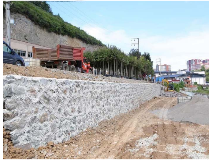
Kaşüstü Mahallesi kirsalında muhtelif alanlarda istinat duvarları asfaltlama çalışmaları yapıldı.
