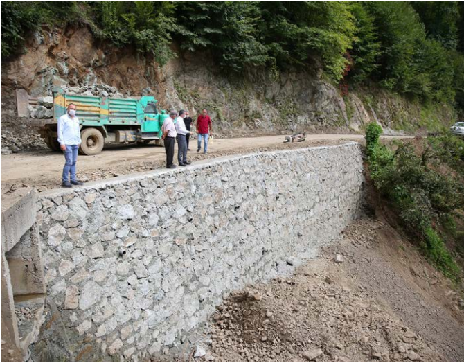
Kıratlı Mahallesi'nde yaşanan sel ve heyelan olaylarının ardından hasarların giderilmesi için 8 farklı noktada 8 ayrı istinat duvarı inşa edildi.
