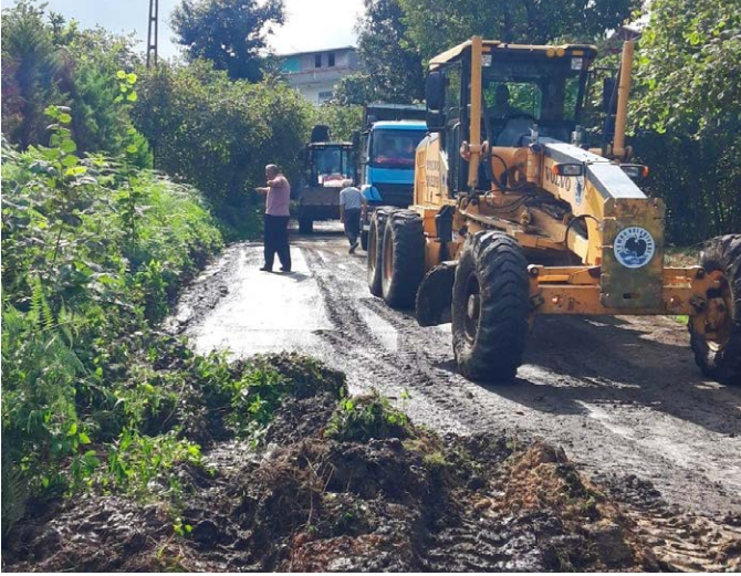
Çamlıca Mahallesi'nde 5 farklı noktada yollardaki dere geçişlerine büz ve boru konularak altyapı çalışması yapıldı. Çamlıca Mahallesi'nde çöp konteynırları yenilendi.
