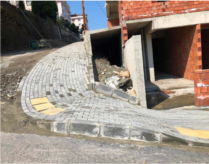
Gürsel Mahallesi girişinde Büyükşehir Belediyesi işbirliği ile kaldırım ve parke çalışması yapıldı. Yıllardır sorunlu halde bulunan yolun düzenlemesi gerçekleştirildi.
