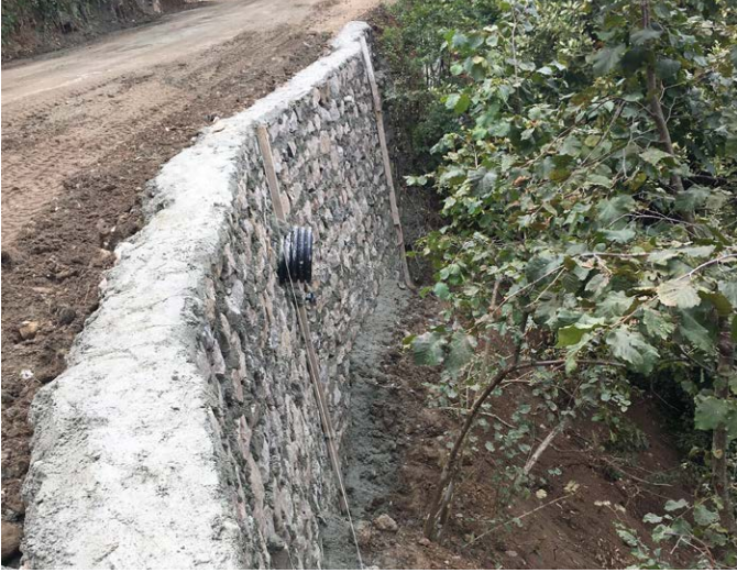
Çınarlı Mahallesi Kılıçtepe Mevkii'nde 3 ayrı noktada istinat duvarları yapıldı.
