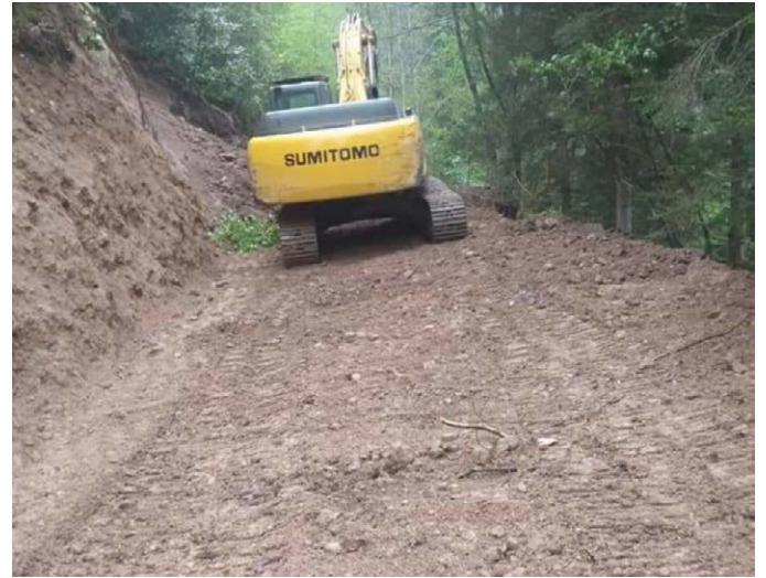
Özdil Mahallesi Halilli-Yavuzselim mevkileri arasında, Köklük-Halilli mevkileri arasında yeni yollar açıldı.
