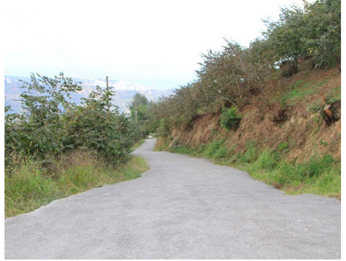
İkisu Mahallesi - Çınarlı Mahallesi bağlantı yolunda betonlama yapıldı.
