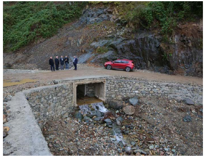
Gülyurdu Mahallesi - Pınarlı Mahallesi bağlantısı olan dere yatağında beton menfez yapılarak bağlantı yolunda yaşanan sorunlar ortadan kaldırıldı. Dere yatağı taş duvarla çevrildi.
