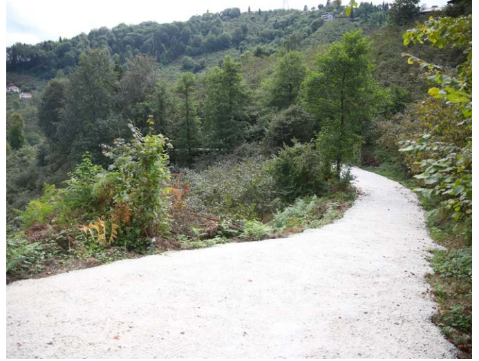
Gürsel Mahallesi Harmançık bağlantı yolu ve Baydarlar Mevkii'nde yol betonlaması yapıldı.
