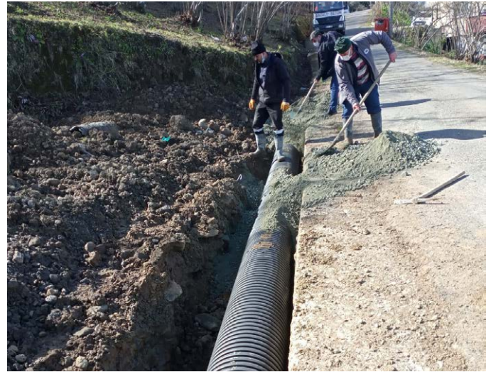
Namikkemal Mahallesi'nde 10 farklı noktada yollardaki dere geçişlerine büz ve boru konularak altyapı çalışması yapıldı. Namikkemal Mahallesi'nde çöp konteynırları yenilendi.
