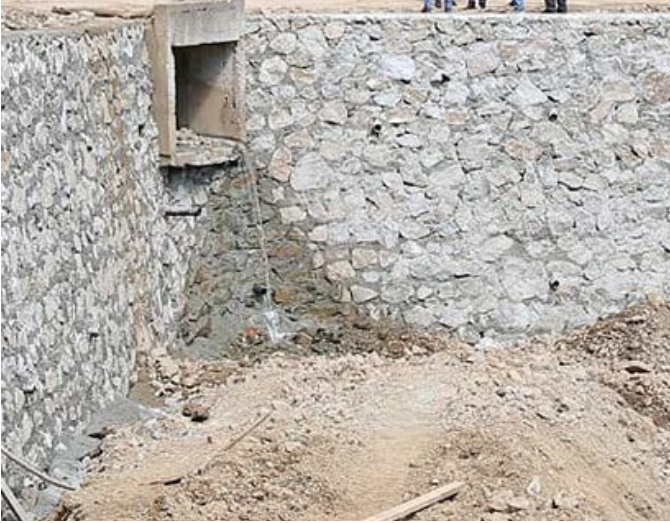
Kıratlı Mahallesi'nde yaşanan sel ve heyelan olaylarının ardından hasarların giderilmesi için 3 farklı noktada 3 ayrı menfez inşa edildi.
