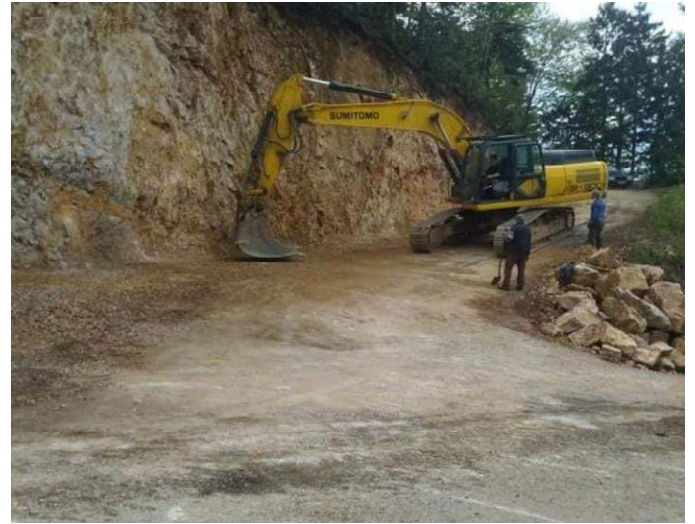
Özdil Mahallesi Durançay Mevkii'nde viraj genişlemesi ve yol betonlaması yapıldı.
