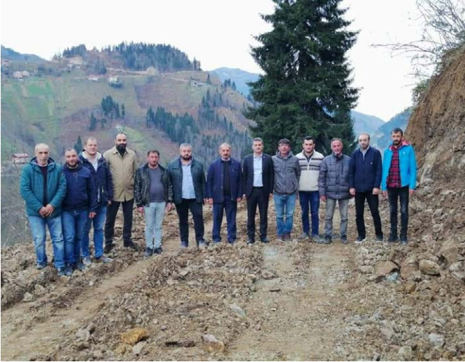
Demirciler Mahallesi Saraç Mevkii'nde 2,5 km yeni yol açıldı.
