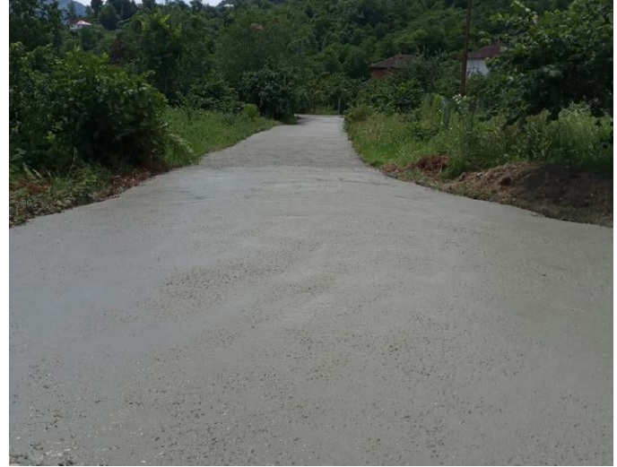
Gürsel Mahallesi Eroğlu Mevkii, Okul Küme Evleri Mevkii ve Deniz Sokak'ta yol betonlaması gerçekleştirildi.
