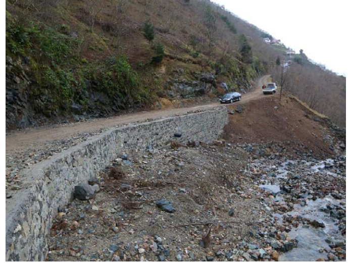
Pınarlı Mahallesi Derebaşı Mevkii'nde istinat duvarı yapıldı.
