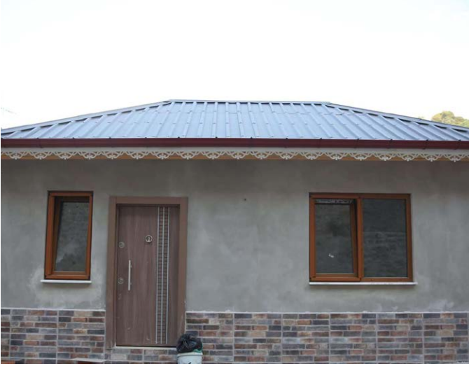
Gürsel Mahallesi'nde muhtarlık ofisi yapıldı.
