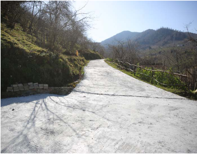
Çınarlı Mahallesi Kılıçtepe Mevkii ve Konak Mevkii bağlantı yolunda betonlama yapıldı.
