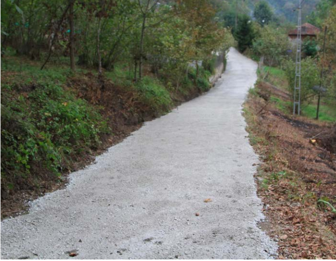
İkisu Mahallesi Karslıođlu Mevkii'nde yol betonlaması yapıldı.
