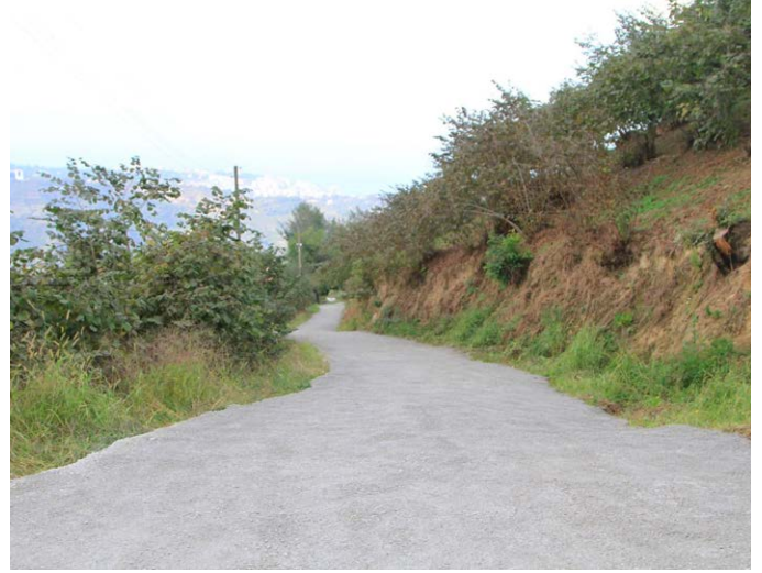
Çınarlı Mahallesi İksu Mahallesi bağlantı yolunda betonlama yapıldı.
