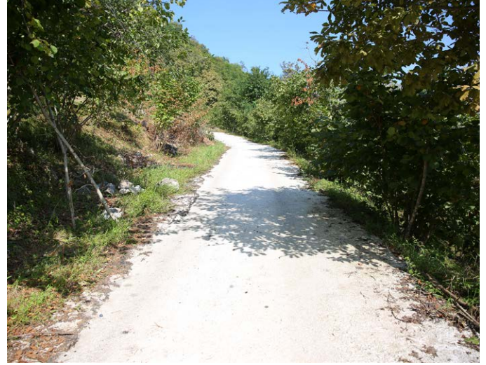
İkisu Mahallesi Ayazma Mevkii'nde yol betonlaması yapıldı.
