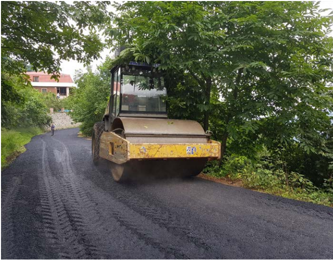
Pınarlı Mahallesi Merkez Mevkii'nde yol asfaltlaması yapıldı.
