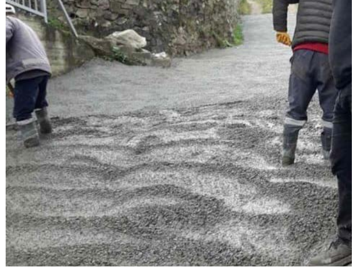
Özdil Mahallesi Durançay-Yavuzselim bağlantı yolunda yol betonlaması yapıldı.
