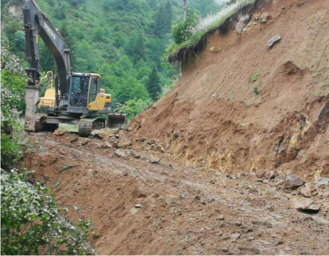
Çamlıyurt Mahallesi Kumluk Mevkii'nde heyelan sonrası yol genişlemesi yapıldı.
