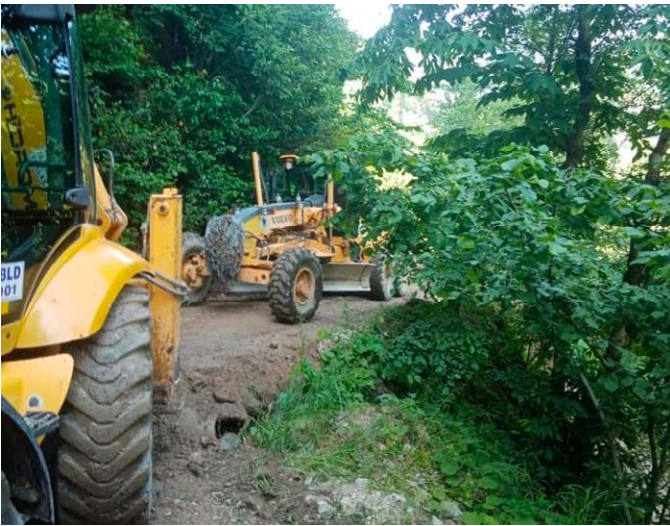
Demirciler Mahallesi'nde 25 farklı noktada yollardaki dere geçişlerine büz ve boru konularak altyapı çalışması yapıldı. Demirciler Mahallesi'nde çöp konteynırları yenilendi.
