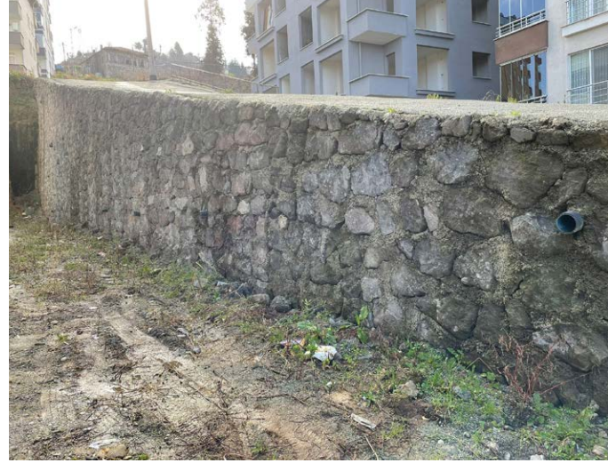
Sancak Mahallesi'nde muhtelif alanlarda istinat duvarları yapıldı.
