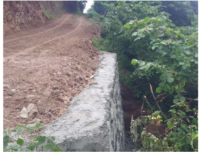
Kayabaşı Mahallesi Hurmalık Mevkii'nde istinat duvarları yapıldı.
