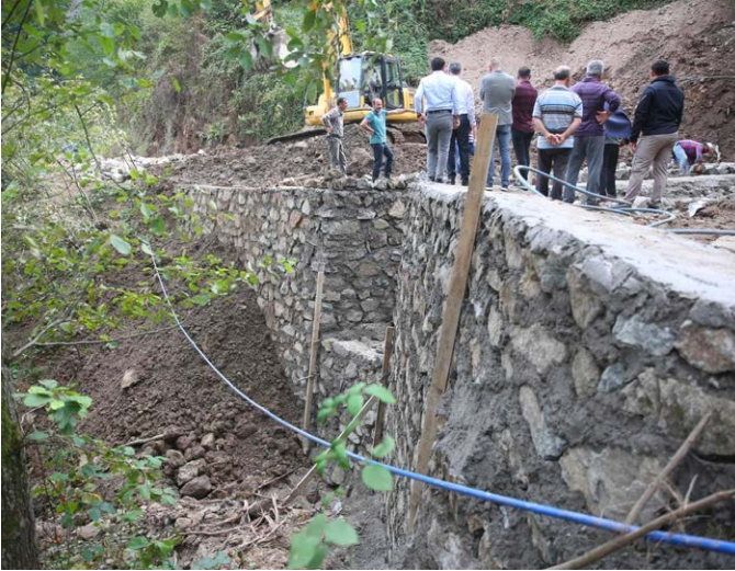
Gürsel Mahallesi Yavuzlar ve Kömürçüoğulları mevkilerinde 5 ayrı noktada istinat duvarları inşa edildi.
