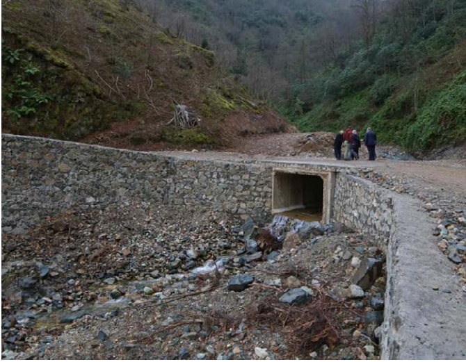
Pınarlı Mahallesi Derebaşı Mevkii'nde iki ayrı menfez yapıldı.
