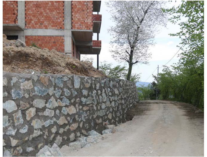
Yokuşlu Mahallesi Camii Mevkii'nde istinat duvarı yapıldı.
