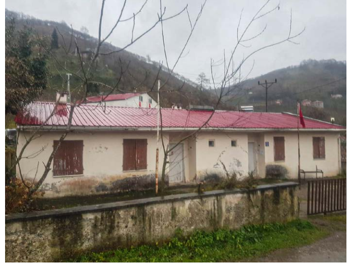
Pınarlı Mahallesi Köy Evi'nin (eski sağlık ocağı) çatısı yenilendi.
