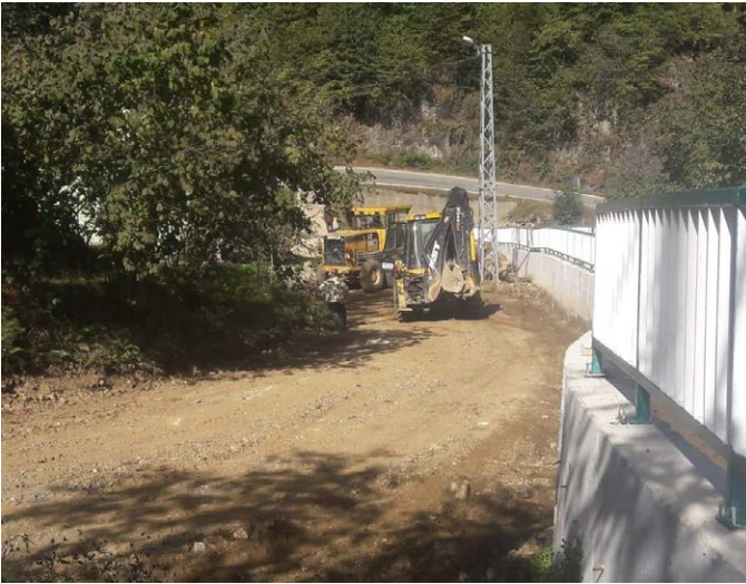
Özdil Mahallesi Gürpınar Mevkii'nde yol genişlemesi yapıldı.
