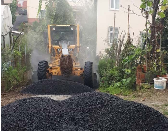
Çamlıca Mahallesi Sirt Mevkii'nde asfaltlama çalışması yapıldı.
