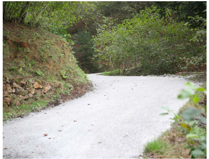
Yenice Mahallesi Yüksekmahalle Mevkii'nde yol betonlaması gerçekleştirildi.
