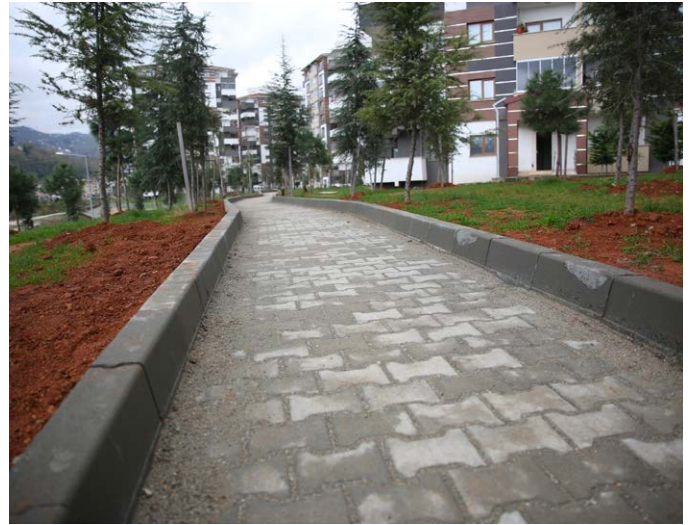
Gürsel Mahallesi'nde bulunan TOKİ konutları içinde yaya ve yürüyüş yolu yapıldı.
