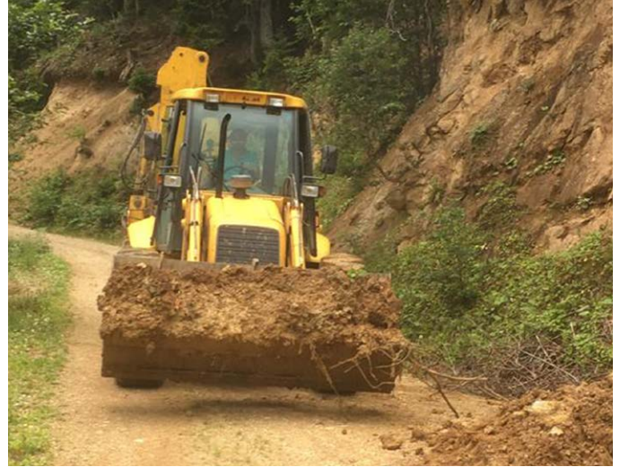
Kılıçlı Mahallesi'nde 15 farklı noktada yollardaki dere geçişlerine büz ve boru konularak altyapı çalışması yapıldı. Kılıçlı Mahallesi'nde çöp konteynırları yenilendi.
