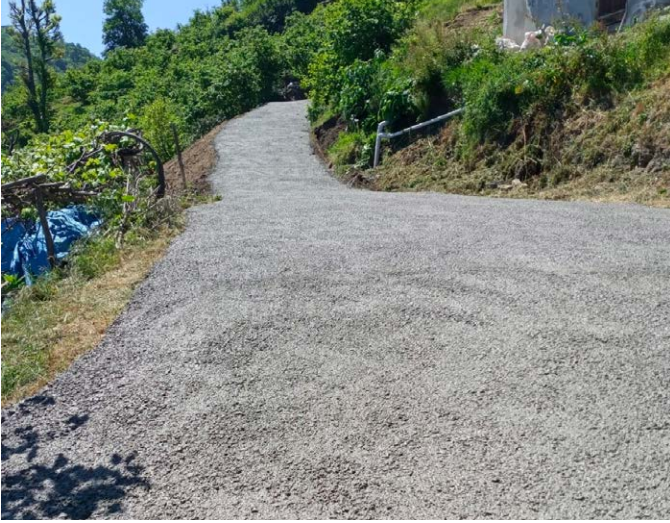
Namikkemal Mahallesi'nde muhtelif alanlarda yol betonlamaları yapıldı.
