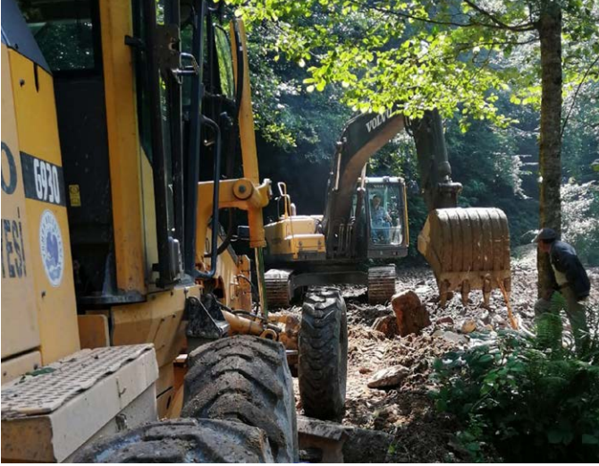
Tepeköy Mahallesi Memala Mevkii'nde yeni yol açıldı.
