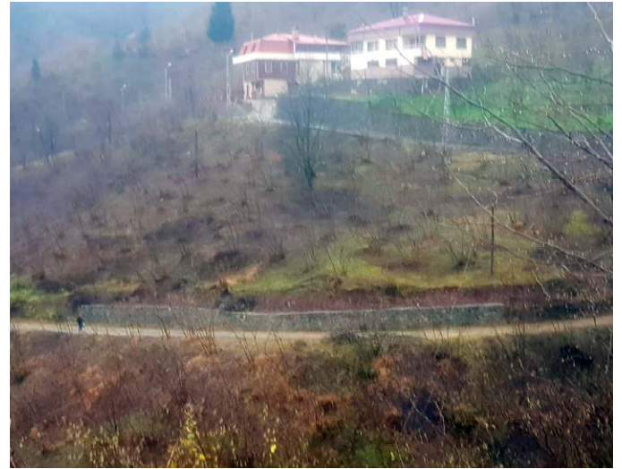
Pınarlı Mahallesi Çarşıposta Mevkii'nde istinat duvarı yapıldı.
