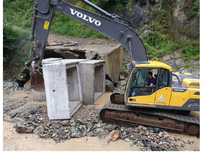
Kıratlı Mahallesi Fırıncık Mevkii'nde kare menfez çalışması gerçekleştirildi.
