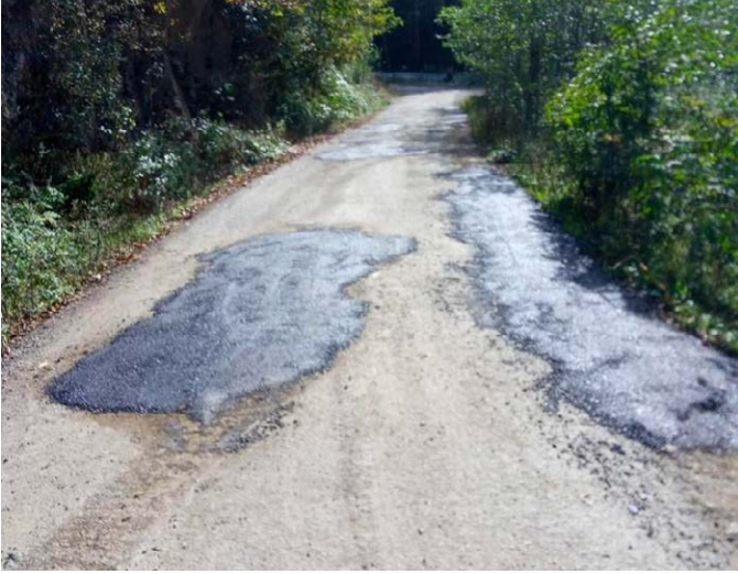
Yenice Mahallesi'nde asfalt yama çalışması gerçekleştirildi.
