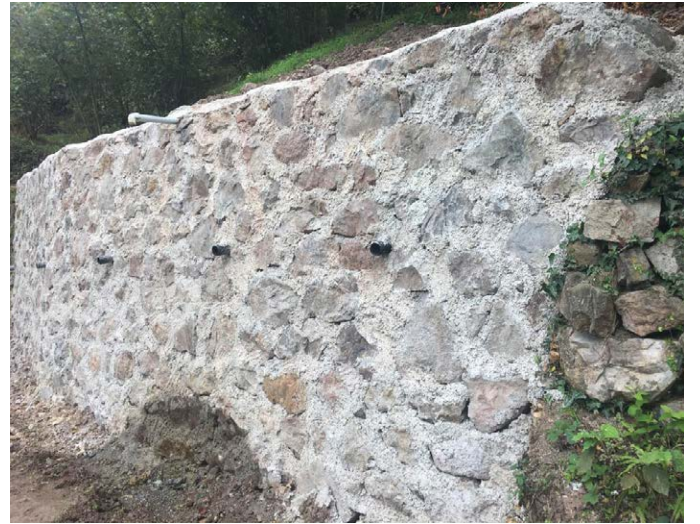
Kayabaşı Mahallesi Armutluk Mevkii'nde 4 ayrı istinat duvarı inşa edildi.
