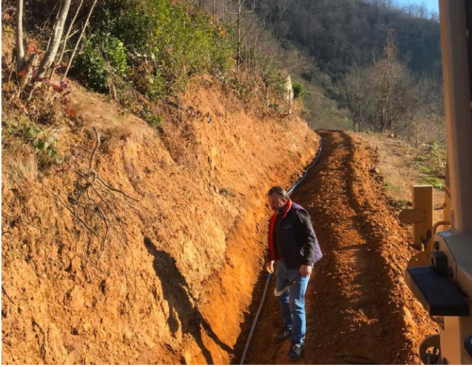
Taşdelen Mahallesi Örgülü Küme Evleri Mevkii'nde 50 yıllık su şebekesinin yenilenmesi için kanal açma çalışması yapıldı.
