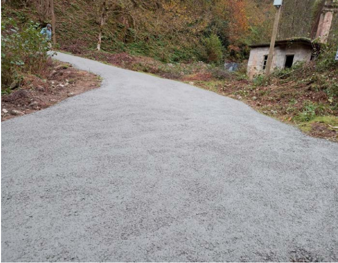
Taşdelen Mahallesi Değirmen Mevkii'nde yol betonlaması gerçekleştirildi.
