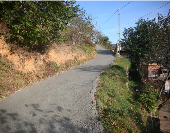
Özdil Mahallesi Hallilli Mevkii'nde yol betonlaması yapıldı.
