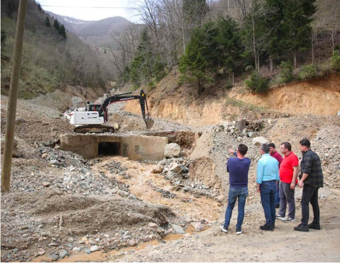
Kıratlı Mahallesi'nde menfez temizliği yapılarak dolan menfezler boşaltıldı.
