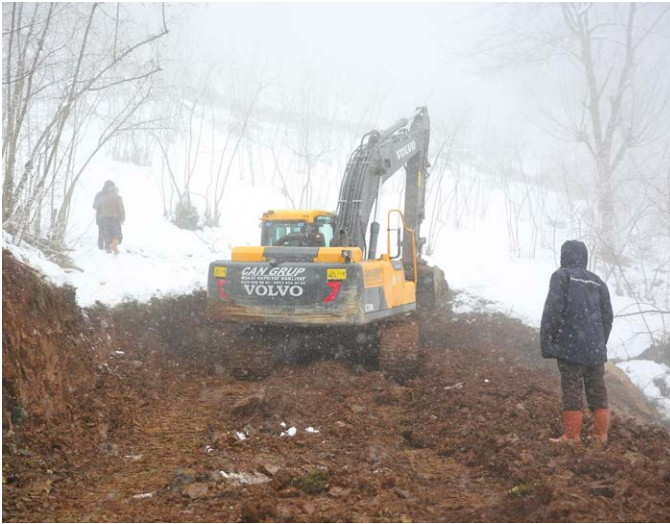
Özdil Mahallesi Yavuzselim, Durançay, Yenimahalle mevkilerinde yeni yollar açıldı.
