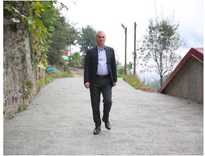
Tepeköy Mahallesi Karahasanlı Küme Evleri Mevkii'nde yol betonlaması yapıldı.
