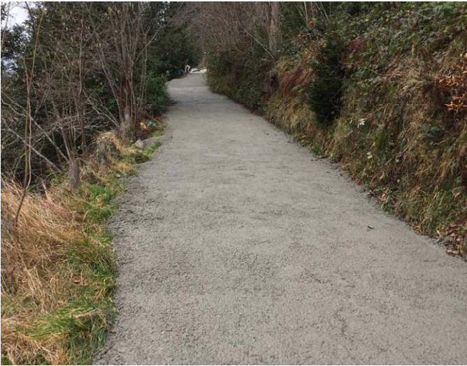
Oymalı Mahallesi Cumhuriyet Mevkii'nde mezarlık yolu betonlandı.
