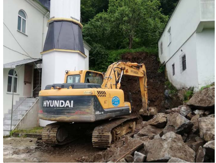
Oymalı Mahallesi Yeşilpınar Cami avlusu betonlandı, cami yanında istinat duvarı yapıldı.
