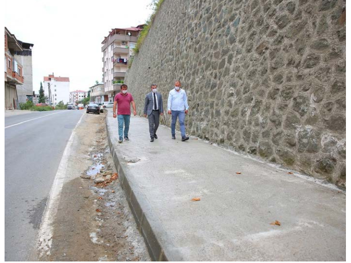
Namikkemal Mahallesi 2. Oymalı Caddesi'nde altyapı ve kaldırımlar imalatları yapıldı.
