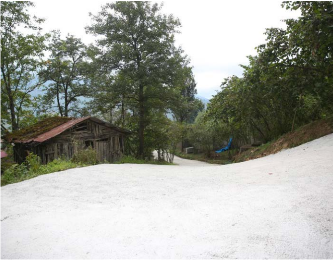
Taşdelen Mahallesi Yiğciler Mevkii'nde yol betonlaması gerçekleştirildi.
