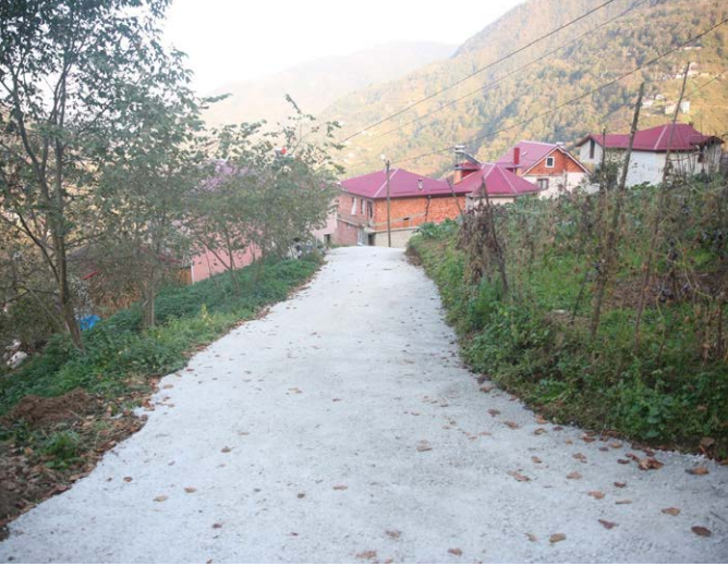
Özdil Mahallesi Yalçınlar Mevkii'nde yol betonlaması yapıldı.
