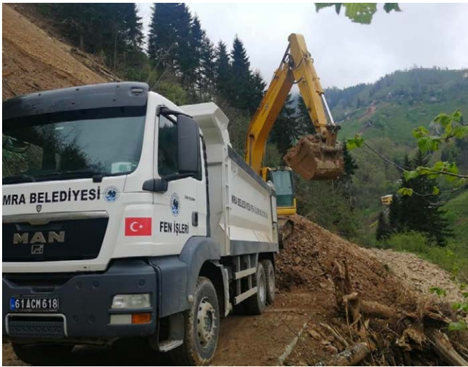
Maden Mahallesi'nde 5 farklı noktada yollardaki dere geçişlerine büz ve boru konularak altyapı çalışması yapıldı. Maden Mahallesi'nde çöp konteynırları yenilendi.
