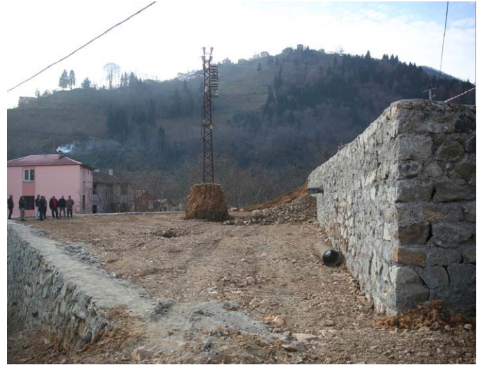
Özdil Mahallesi Yatılı Kur'an Kursu yanında mülkiyeti belediyemize ait alanda spor sahası yapımı için, istinat duvarları ve hafriyat çalışmaları tamamlandı. Yeni dönemde spor sahası inşaatı gerçekleştirilecektir.
