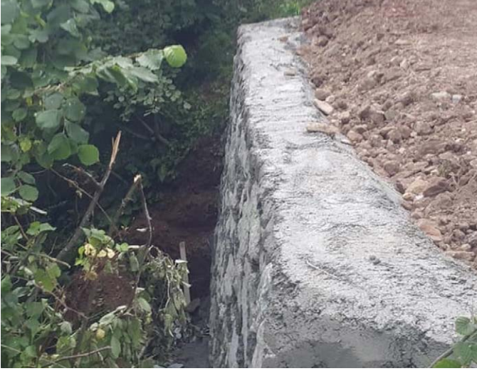
Kayabaşı Hurmalık Mevkii'nde Kayabaşı-Gürsel bağlantı yolunda istinat duvarı yapıldı.
