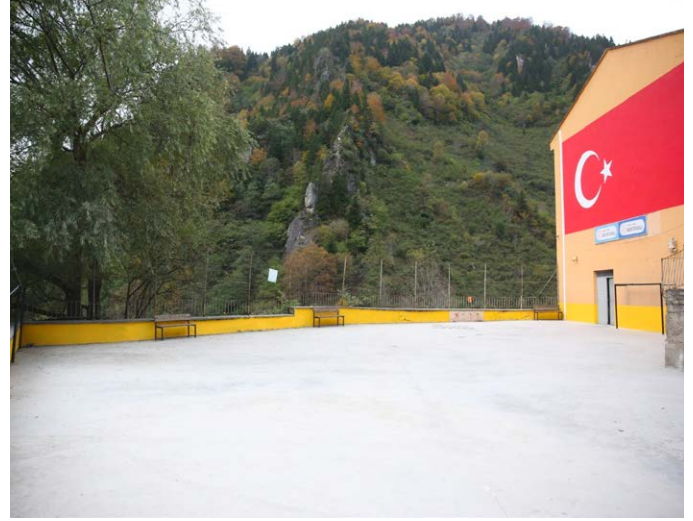
Çamlıyurt İlkokulu bahçesi belediyemiz tarafından betonlandı.
