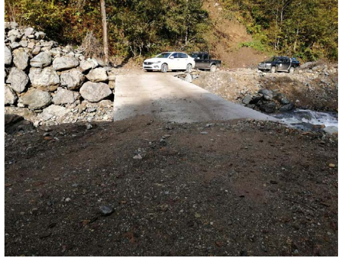
Demirciler Mahallesi Ayor Mevkii'nde selde zarar gören köprü yenilendi.
