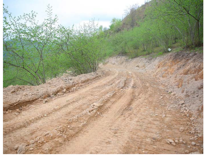
Ocak Mahallesi Çakallı Mevkii ve Merkez Mevkii'nde yeni yollar yapıldı.
