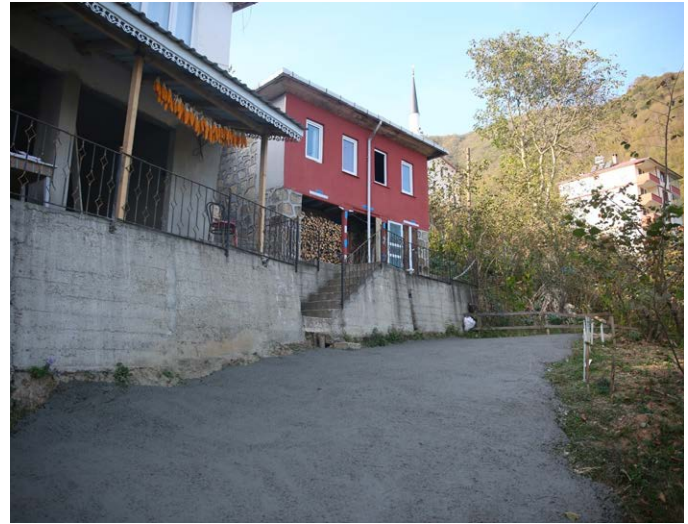
Özdil Mahallesi Köklük Mevkii'nde yol betonlaması yapıldı.
