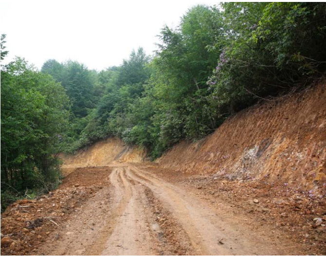
Taşdelen Mahallesi - Sincankaya - Yayla bağlantı yolu ve mahalle genelinde yol genişleme çalışması gerçekleştirildi.
