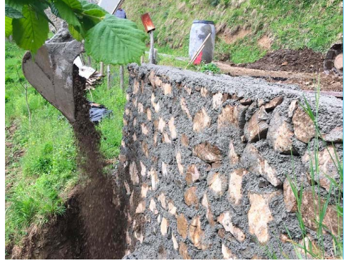
Özdil Mahallesi genelinde 8 farklı noktada istinat duvarları yapıldı.
