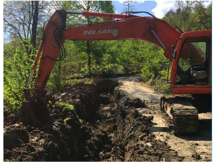
Şanlı Mahallesi Düzlük Mevkii'nde yol zeminindeki kayma nedeniyle drenaj çalışması yapıldı.
