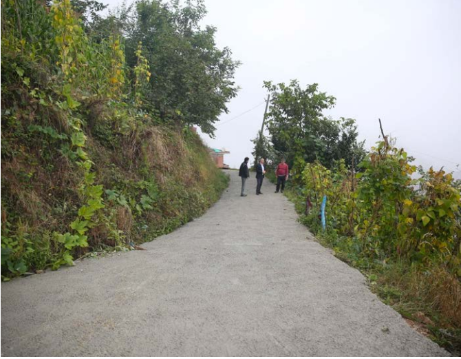
Tepeköy Mahallesi Recepli Mevkii'nde yol betonlaması yapıldı.
