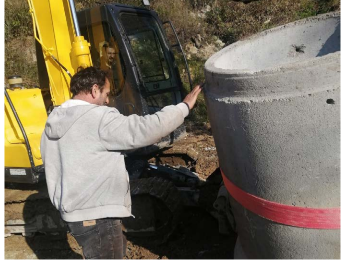
Taşdelen Mahallesi Örgülü Mevkii'nde menfez yapıldı.
