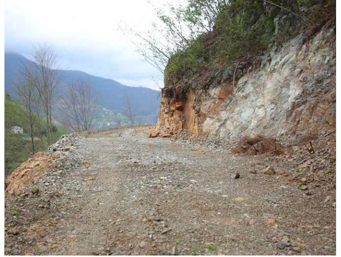
Kömürcü Mahallesi Kömürcüler Mevkii'nde 5 farklı noktada yeni yollar yapıldı.
