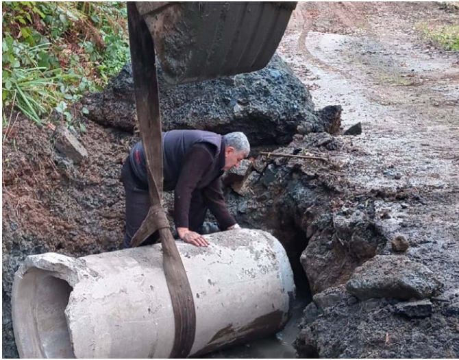
Taşdelen Mahallesi'nde 20 farklı noktada yollardaki dere geçişlerine büz ve boru konularak altyapı çalışması yapıldı. Taşdelen Mahallesi'nde çöp konteynırları yenilendi.
