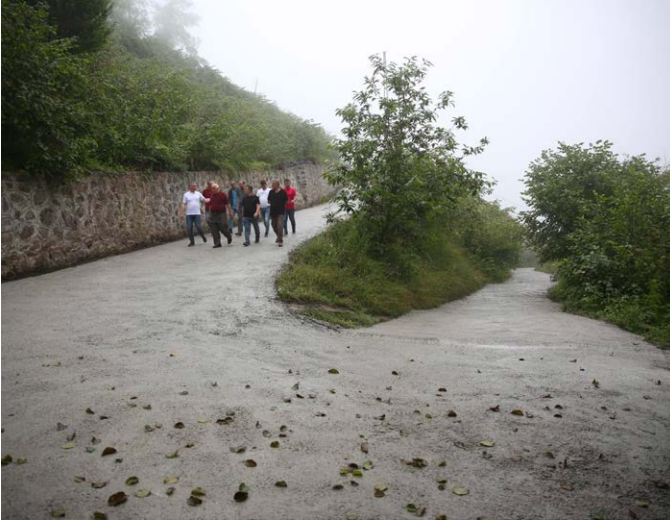
Pınarlı Mahallesi Okul Küme Evleri Mevkii'nde yol betonlaması yapıldı.
