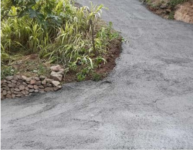
Kılıçlı Mahallesi Kahramanlar Mevkii'nde yol betonlaması yapıldı.
