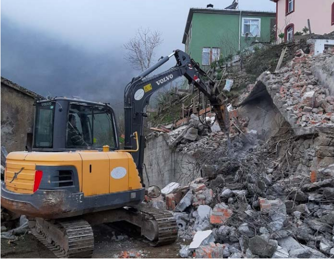
Kıratlı Mahallesi Çepnili Mevkii'nde metruk binanın yıkımı gerçekleştirilerek cami çevresi düzenleme çalışmaları yapıldı.
