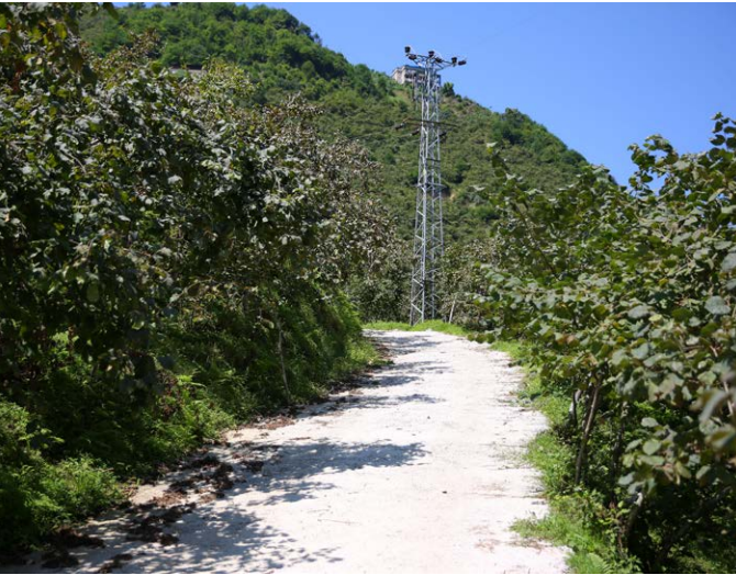
Gülyurdu Mahallesi Arduç Mevkii'nde yol betonlaması gerçekleştirildi.
