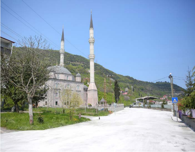
Gürsel Mahallesi eski Oymalı Caddesi'nde yol betonlaması gerçekleştirildi.
