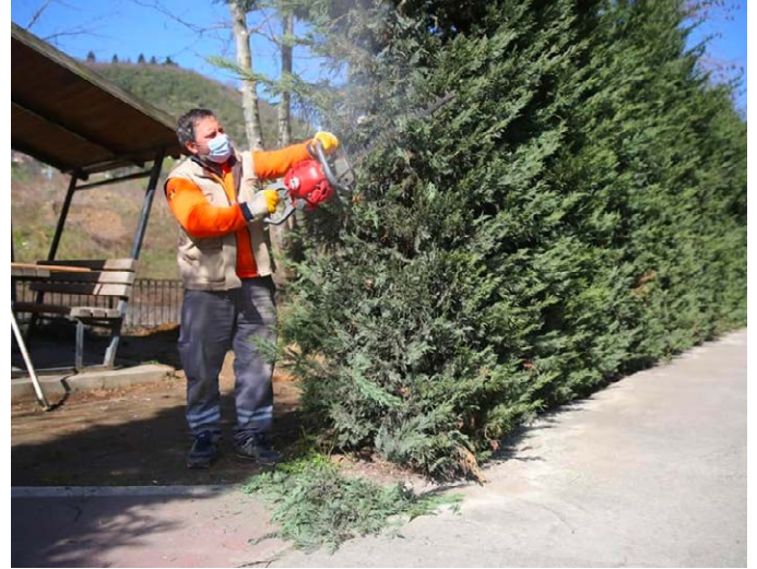
Namikkemal Mahallesi'nde bulunan İLBANK Parkı'nda gerekli bakım, onarım ve düzenleme çalışmaları ivedilikle gerçekleştirildi.
