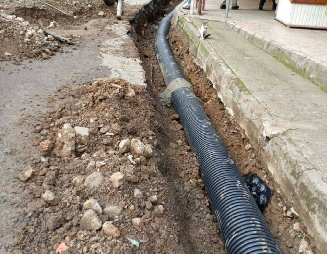
Kaşüstü Mahallesi kırsalında 35 farklı noktada yollardaki dere geçişlerine büz ve boru konularak altyapı çalışması yapıldı.
