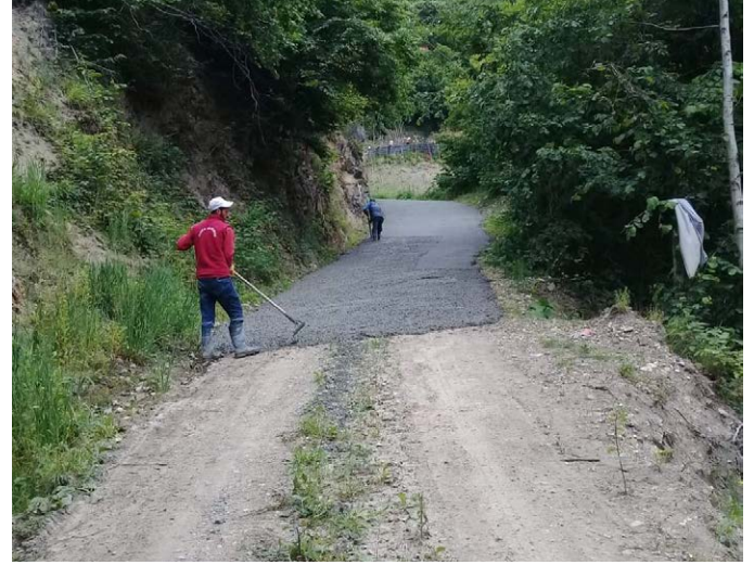
Kıratlı Mahallesi Hozarak Mevkii'nde yol betonlaması yapıldı.
