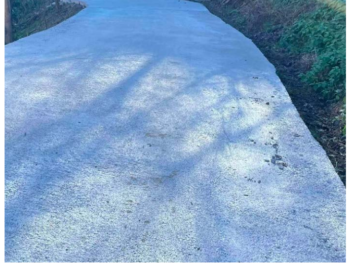
Ocak Mahallesi Çakallı Mevkii'nde muhtelif alanlarda yol betonlaması gerçekleştirildi.
