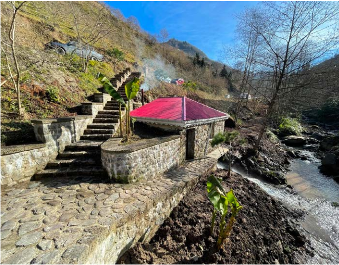
İkisu Mahallesi Başmahalle Mevkii'nde yaklaşık 150 yıllık mazisi olan, kullanılmaz haldeki mısır değirmeni yenilendi.
